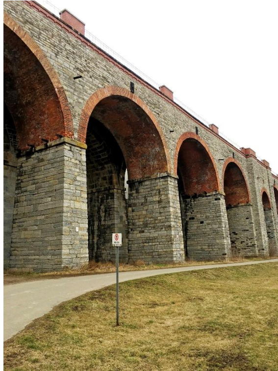
Obrázek 5: Hranické viadukty I. Zdroj: vlastní fotografie ze dne 25. 3. 2018
