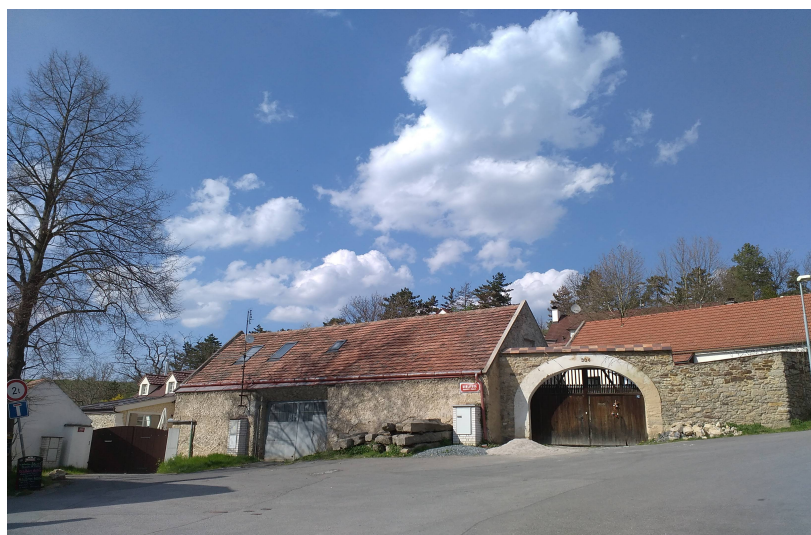
Obr. 39: Pohled přes náves na usedlost č. p. 304 (c). (fotografie vlastní)
