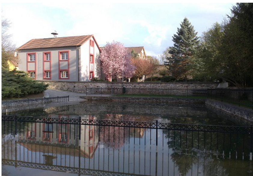
Obr. 58: Malá vodní nádrž (1) se nachází ve středu historické části obce. (fotografie vlastní)
