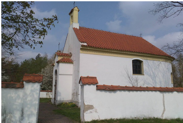
Obr. 125: Dva topoly zasazené před vchodem kapličky (1). Vzádu kamenná zeď (b) z roku 1704 zůstala zachována v původní podobě. (fotografie vlastní)
