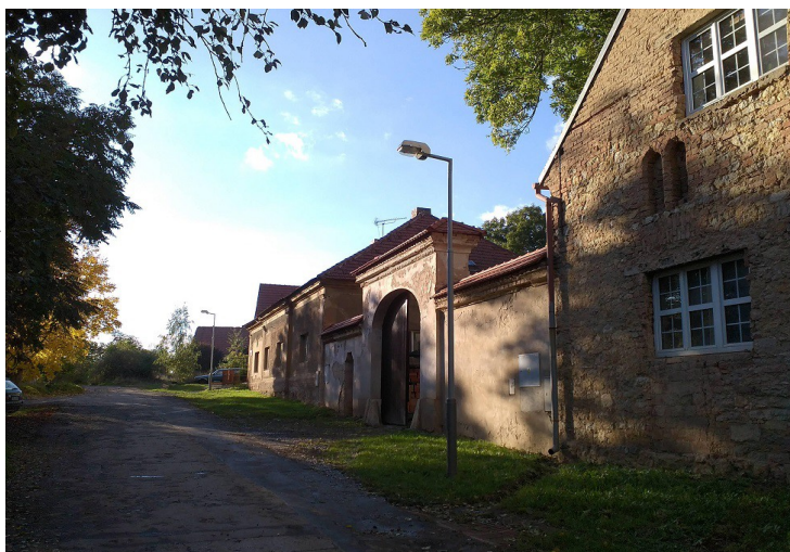
Obr. 151: Pohled do ulice Skopců. Vpravo hospodářská budova stavení č. p. 6 (dnes 48) (b) se zadržnými původními okny. Dále brána a stavení č. p. 3 (dnes 28) (a). (fotografie vlastní)
