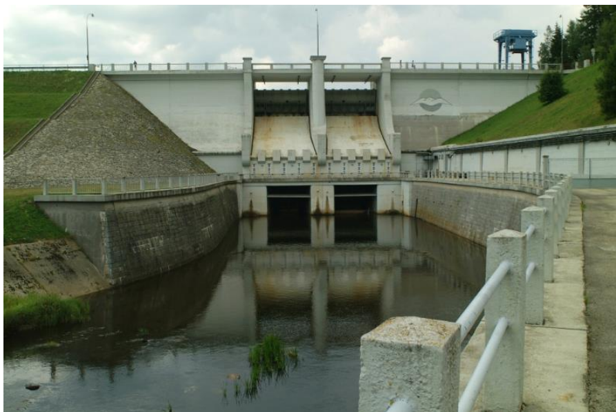
Obr. 13 Vodní elektrárna Lipno I [12]
