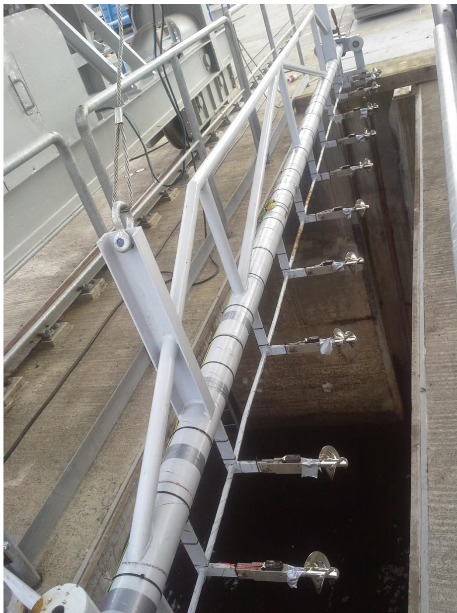
Obr. 6 Měření průtoku hydrometrickými vrtulemi na VE Kamýk
