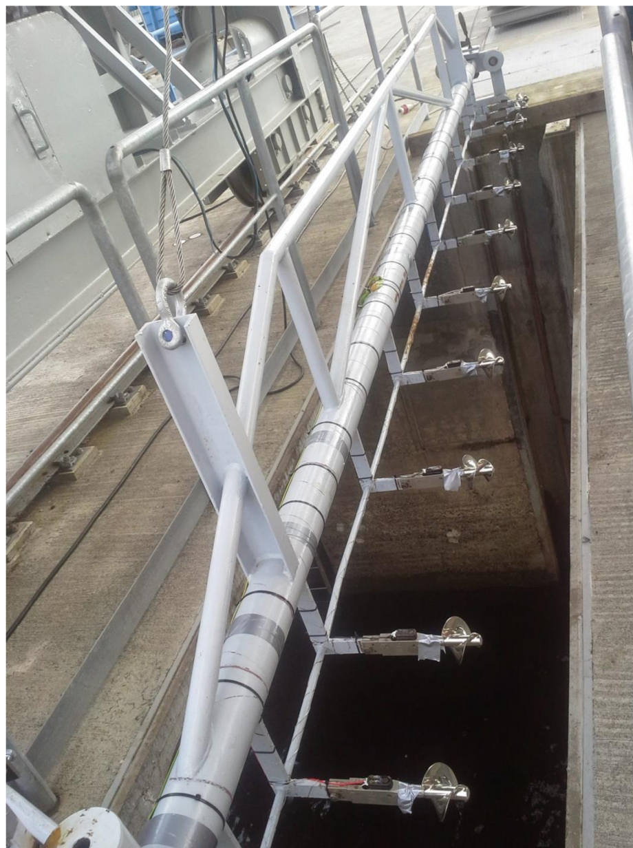
Obr. 6 Měření průtoku hydrometrickými vrtulemi na VE Kamýk
