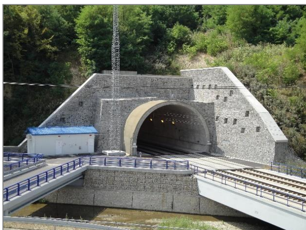
Obr. 49 Severný portál tunela Turecký vrch
