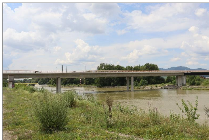
Obr. 48 Nový cestný most v Trenčíne
