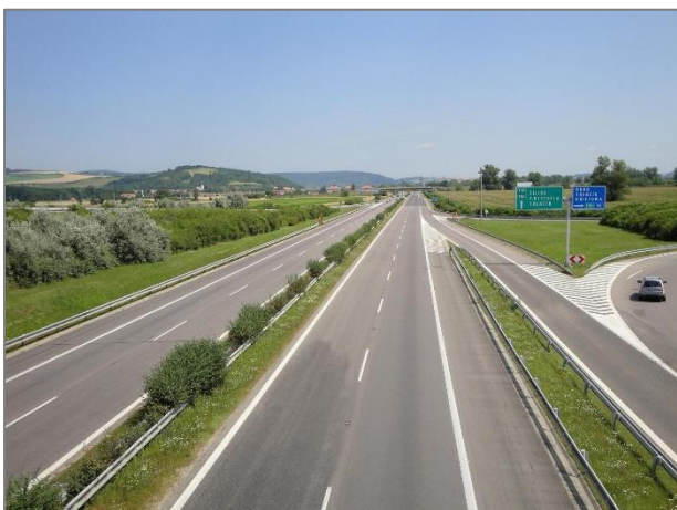
Obr. 47 Diaľnica D1 pri obci Drietoma
