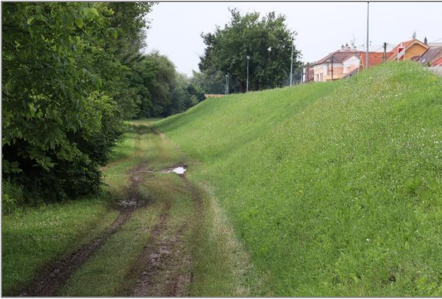
Obr. 17 Ochranné hrádze v Trenčíne
