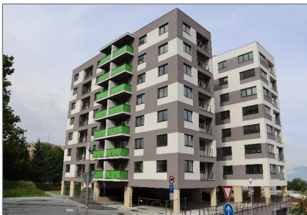
Obr. 38 Výstavba bytového domu na Novomeského ulici
