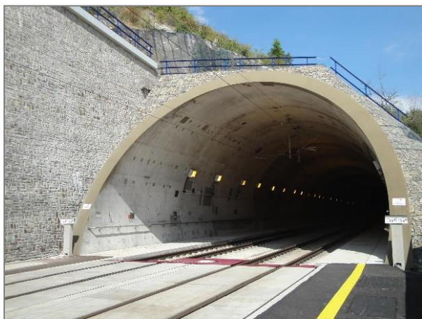
Obr. 51 Južný portál tunela Turecký vrch
