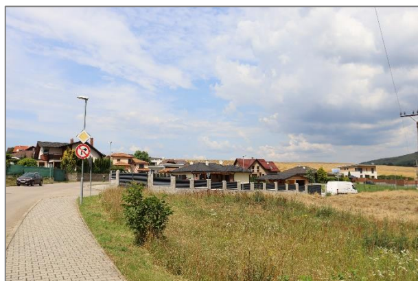
Obr. 40 Výstavba rodinných domov v obci Soblahov
