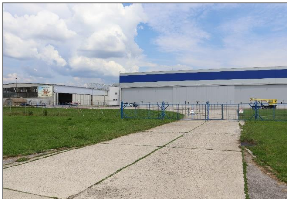
Obr. 45 Areál Leteckých opravovní Trenčín
