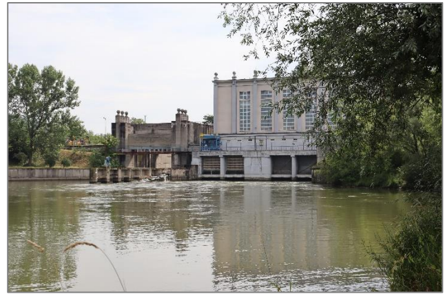
Obr. 18 Vodná elektrárň Trenčín
