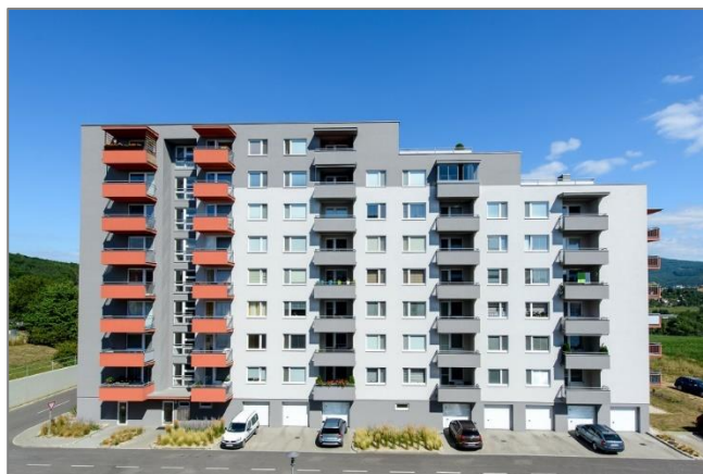
Obr. 39 Výstavba bytového domu na Liptovskej ulici
