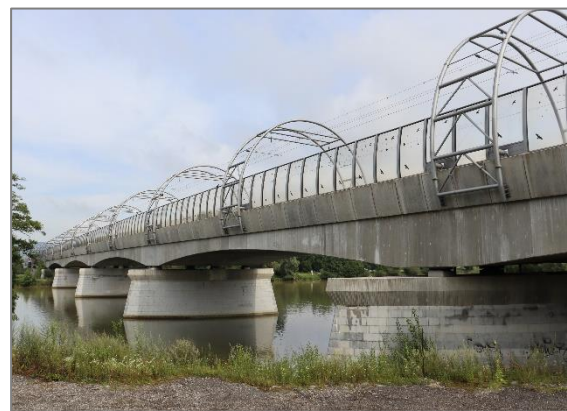
Obr. 17 Nový železničný most v Trenčíne (T. Mikulovský, 07/2020)
