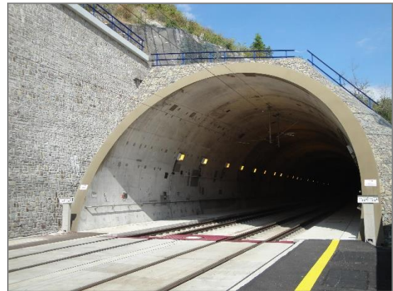
Obr. 15 Južný portál tunela Turecký vrch (T. Mikulovský, 08/2013)
