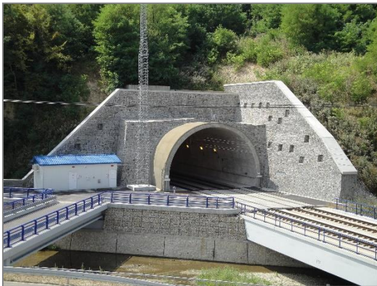
Obr. 14 Severný portál tunela Turecký vrch (T. Mikulovský, 08/2013)
