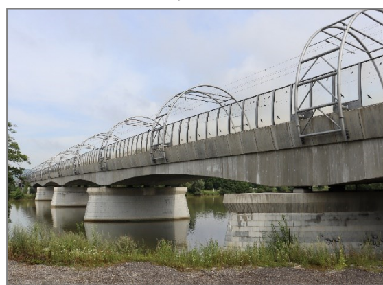
Obr. 17 Nový železničný most v Trenčíne (T. Mikulovský, 07/2020)
