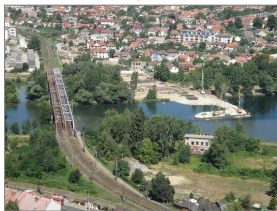
Obr. 16 Starý železničný most v Trenčíne (T. Mikulovský, 08/2013)
