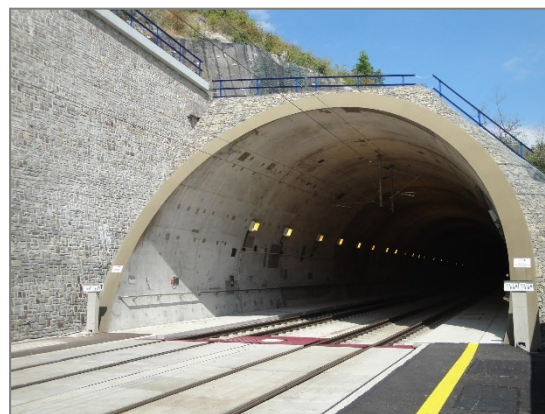
Obr. 15 Južný portál tunela Turecký vrch (T. Mikulovský, 08/2013)
