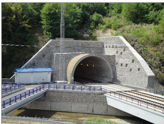
Obr. 14 Severný portál tunela Turecký vrch (T. Mikulovský, 08/2013)
