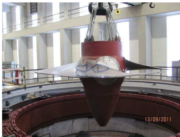
Obr. 1.5 Oběžné kolo Kaplanovy turbíny[13]
