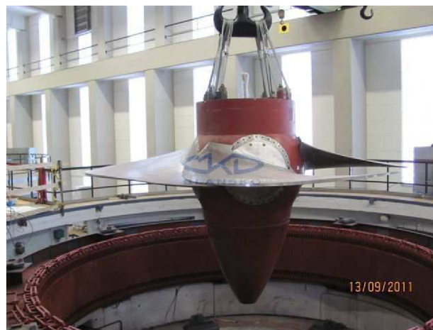
Obr. 1.5 Oběžné kolo Kaplanovy turbíny[13]
