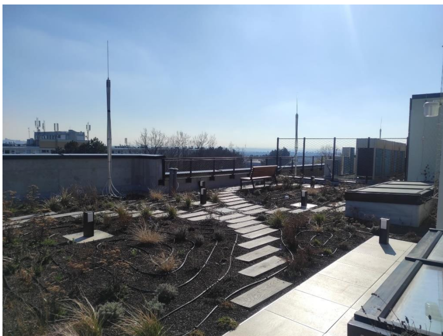
Obrázek 2: Extenzivní část zelené střechy
