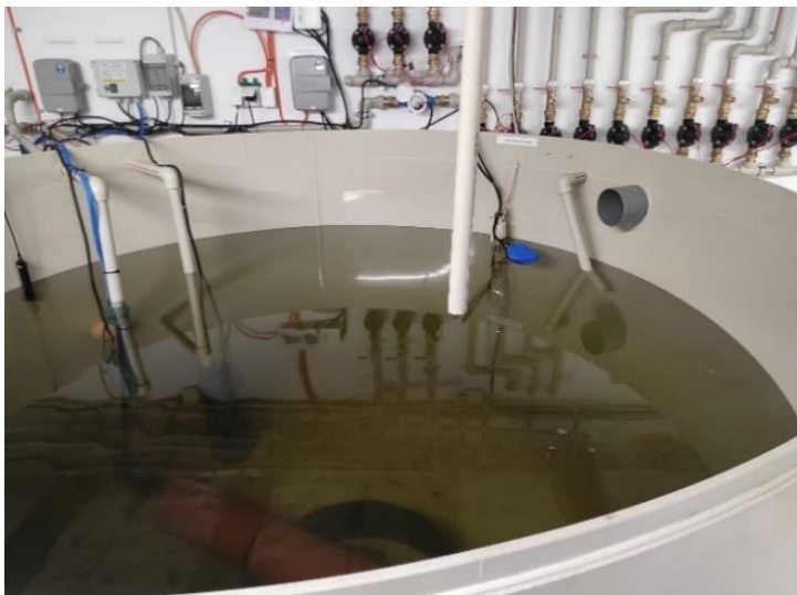
Obrázek 8: Svod dešťové vody
