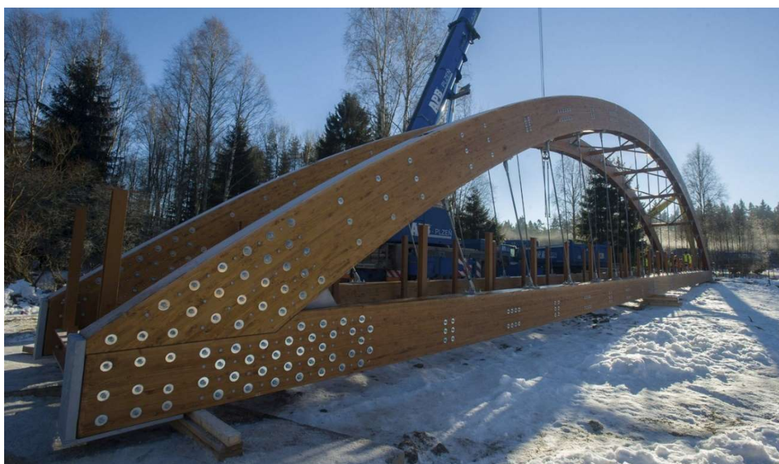
Obrázek 21: Kombinace svorníků a ocelových plechů – Lávka přes studenou Vltavu (Idnes.cz 2013)
