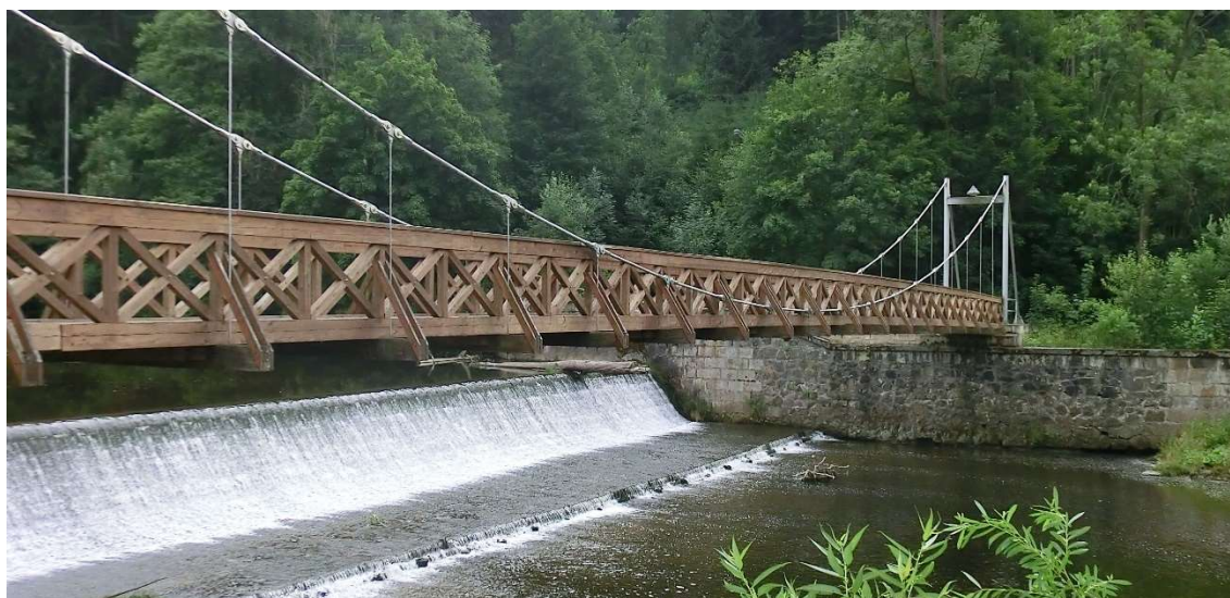
Obrázek 18: Visutá dřevěná lávka s výztužným nosníkem – Benešov u Semil (wikimedia.org, 2015)
