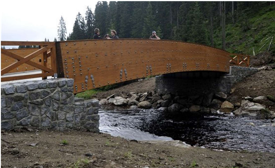
Obrázek 11: Trémová konstrukce z lepených oblouků-Lávka na Modravě (Idnes, 2014)
