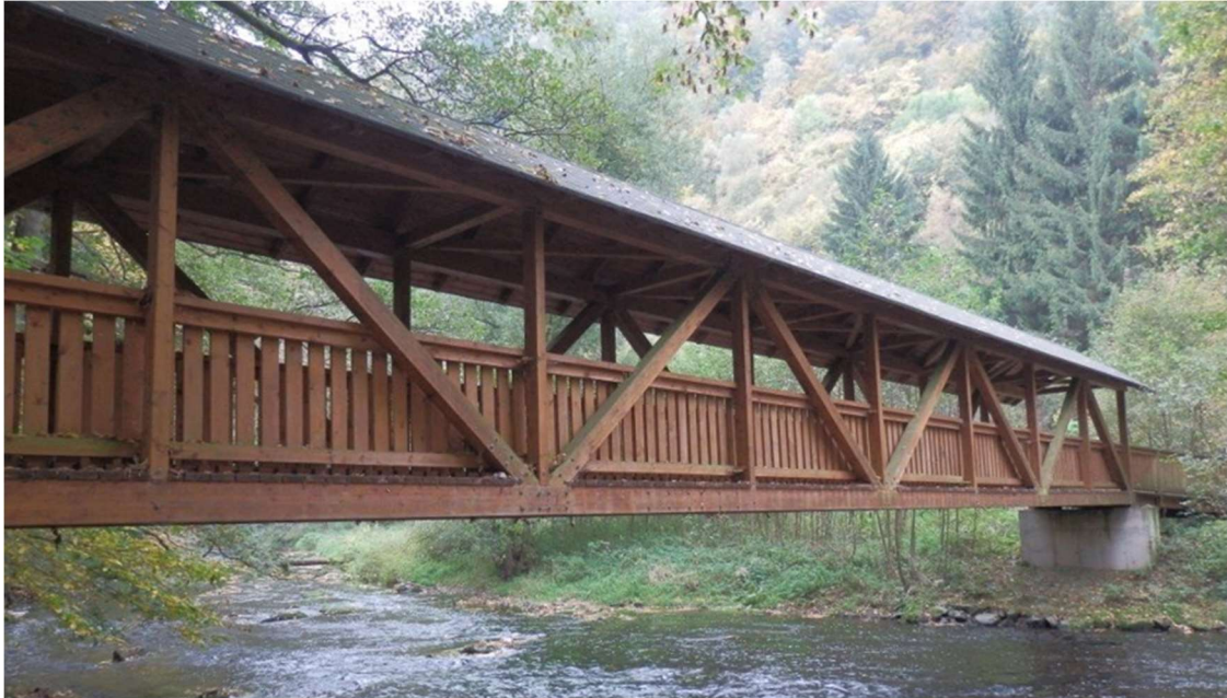
Obrázek 10: Příhradová konstrukce – lávka v Novém městě nad Metují (turistika.cz, 2017)
