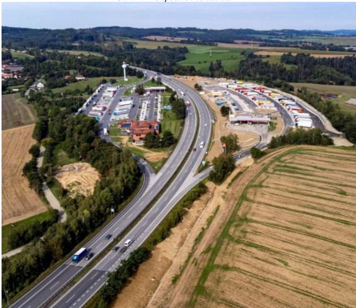
Obr. 18 – Odpočívek na dálnici D1
