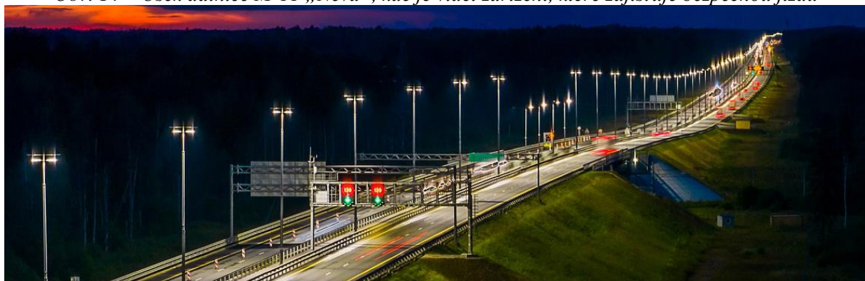
Obr. 14 – Úsek dálnice M-11 „Něva“, kde je vidět zařízení, které zajišťuje bezpečnou jízdu
