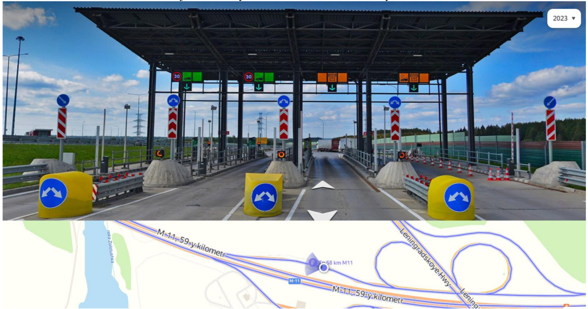
Obr. 12 – Výjezdová mýtná brána na 58 km trasy M-11 „Něva“
