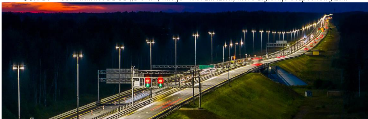
Obr. 14 – Úsek dálnice M-11 „Něva“, kde je vidět zařízení, které zajišťuje bezpečnou jízdu
