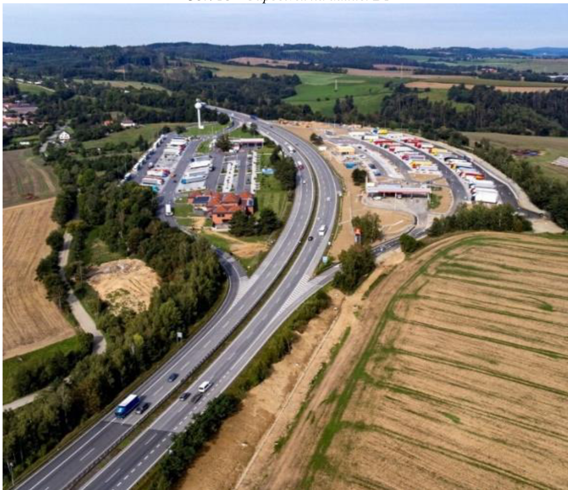
Obr. 18 – Odpočívek na dálnici D1
