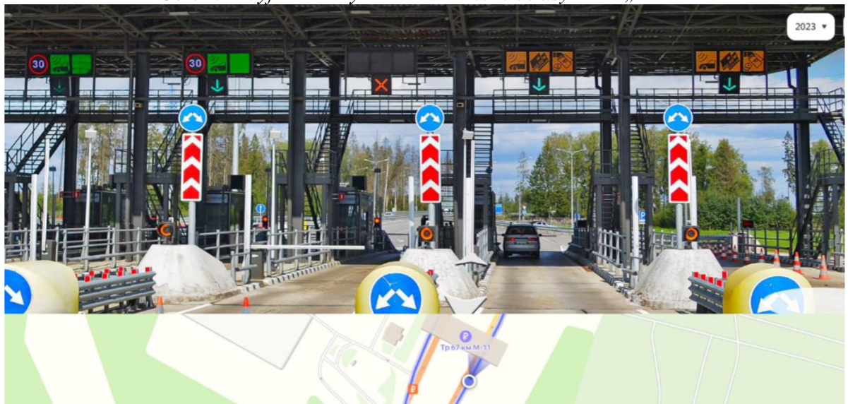
Obr. 13 – Výjezdová mýtná brána na 67 km trasy M-11 „Něva“
