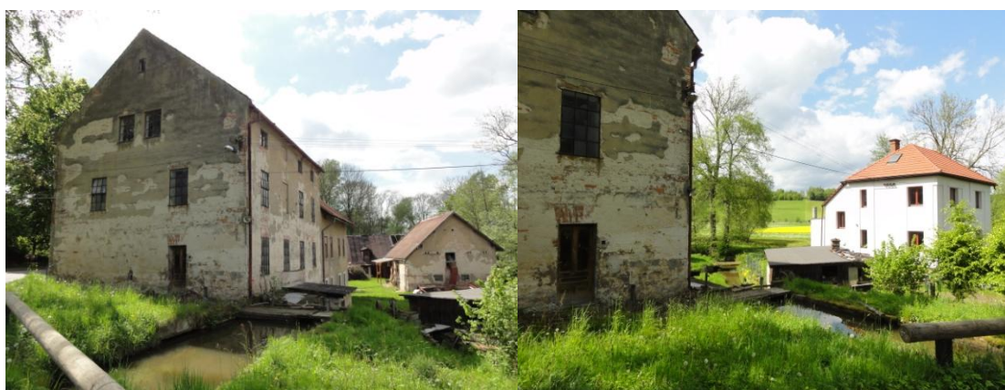
Obrázek 5 - Mlýn Mlýnice, pohled na budovu mlýna a náhon
