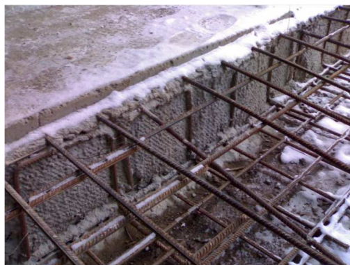
Obrázek 9.47 – Pracovní spára stropní konstrukce z tahokovu [46]
