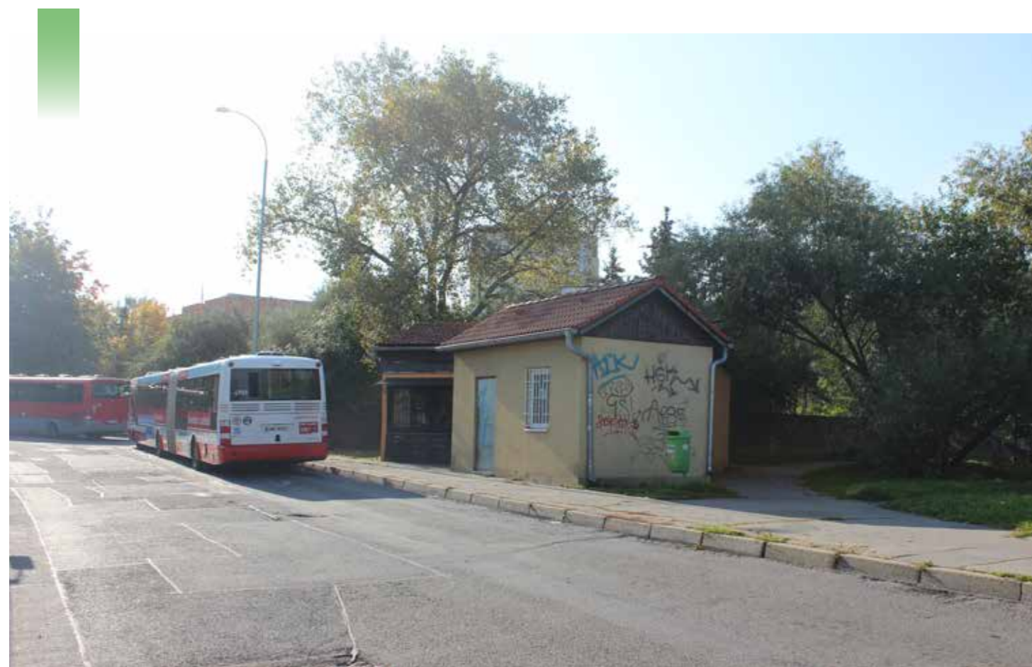
Obr. 24: Konečná stanice autobusů (autor práce 2018)
