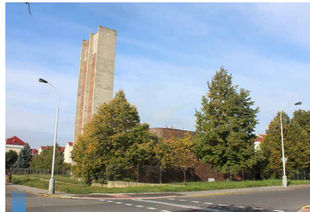
Obr. 27: Výtopna Rohožník (autor práce 2018)
