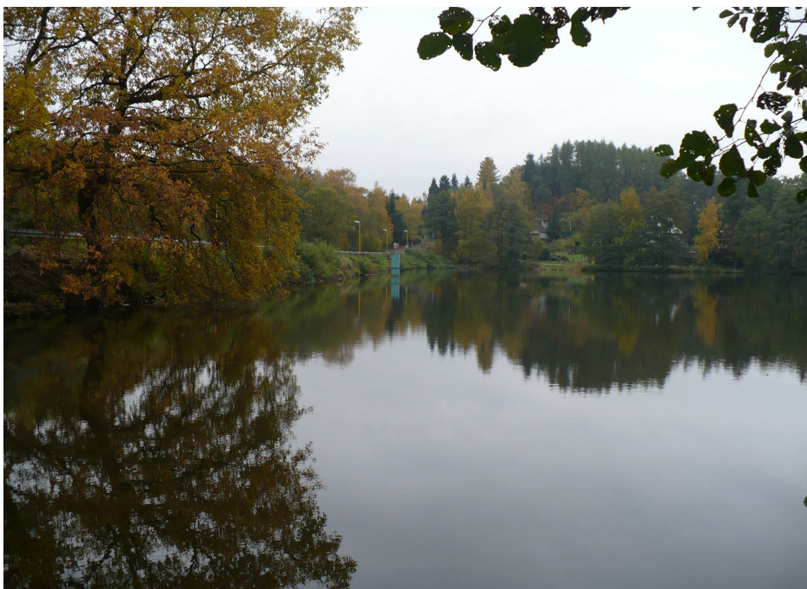
F č. 10 hráz rybníka Požár
