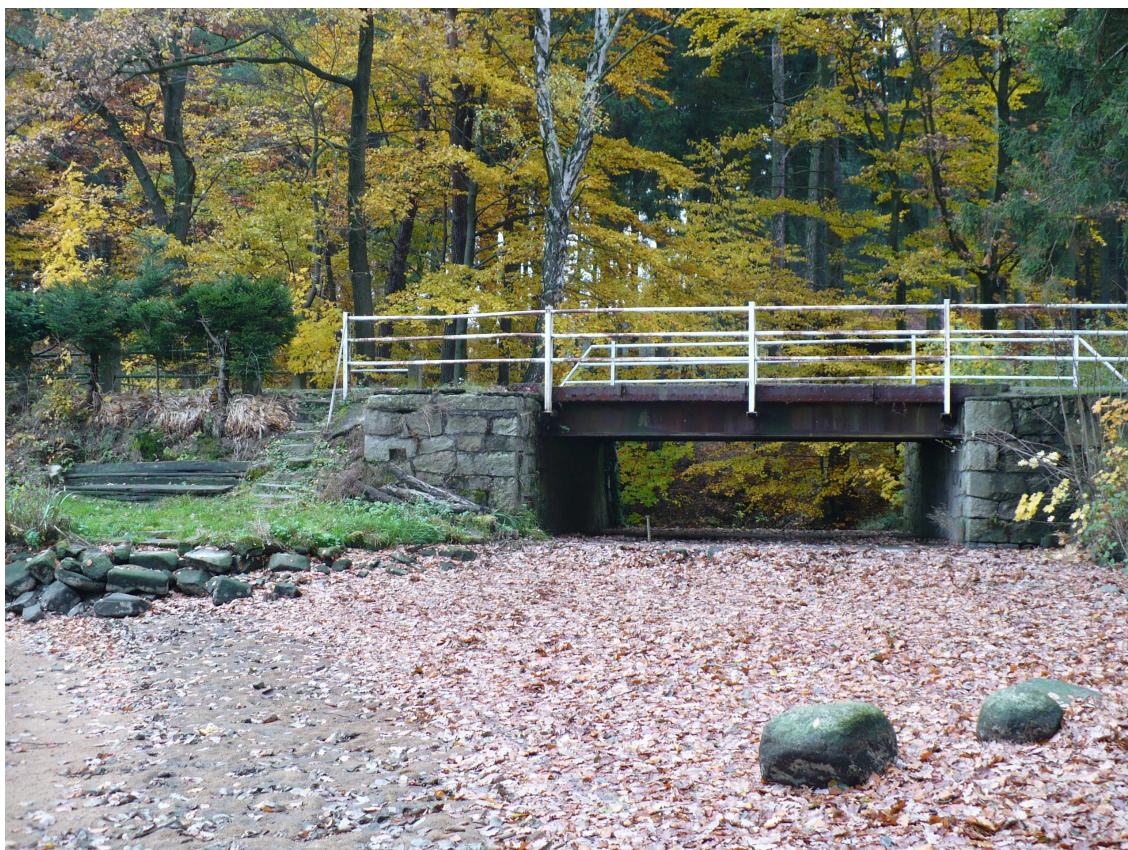
F č. 2 bezpečnostní přeliv na rybníku Vyžlovka
