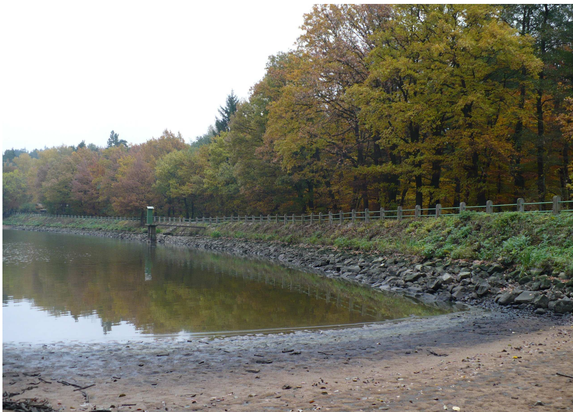
F č. 3 hráz rybníka Vyžlovka
