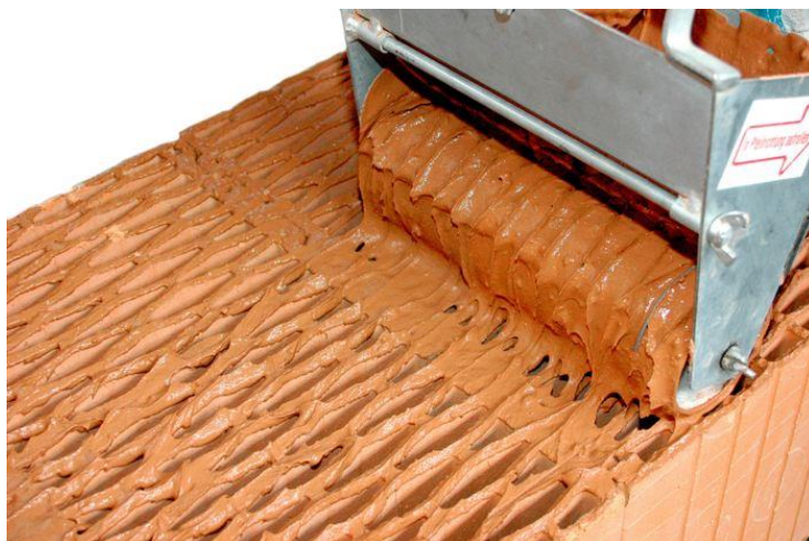
Obrázek č. 13 – Malta nanášená pomocí nanášecího válce [36]
