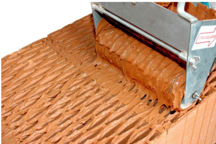
Obrázek č. 13 – Malta nanášená pomocí nanášecího válce [36]
