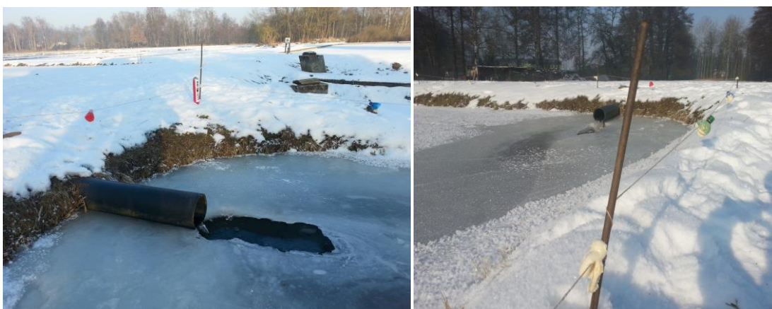
Obr. č. 16 a 17 Instalovaný pachový ohradník
