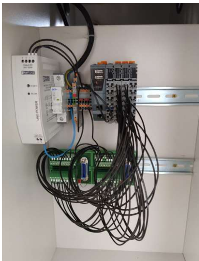
Obrázek 12: PLC s propojenými signálovými cestami Zdroj: vlastní
