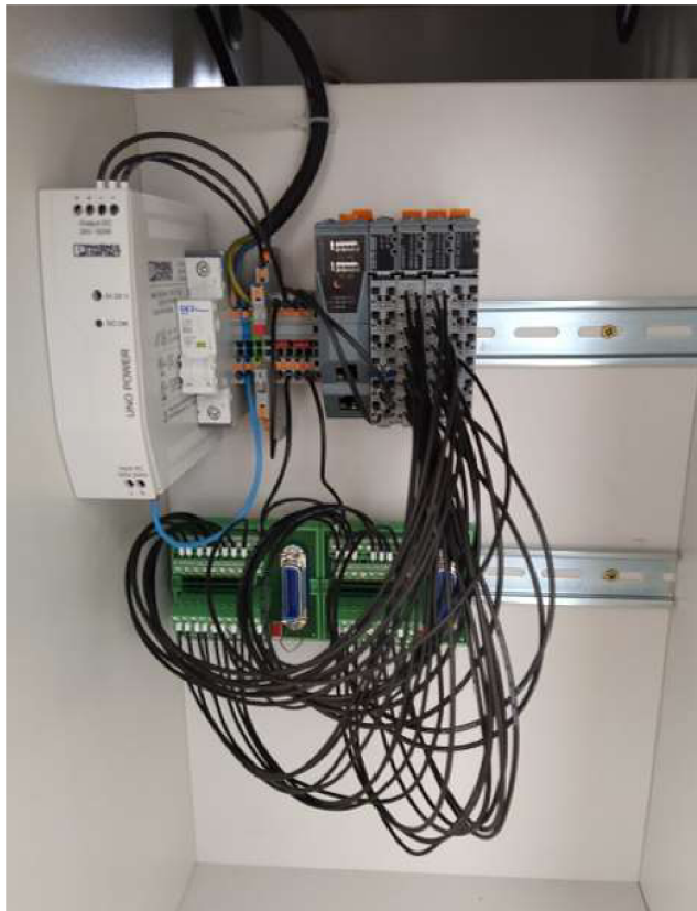
Obrázek 12: PLC s propojenými signálovými cestami Zdroj: vlastní
