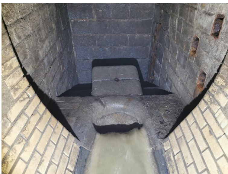
Obr. 8-14 – pohled na nátok do spadiště Š4A a Š4B, na žabí tlamu DN600 a na žulovou vyzdívku s rozrážecím kamenem [zdroj: Lukáš Havlíček]
