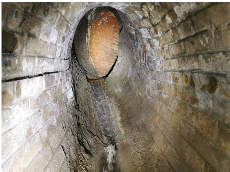
Obr. 8-32 – pohled na přepojení do nové stoky [zdroj: Lukáš Havlíček]
