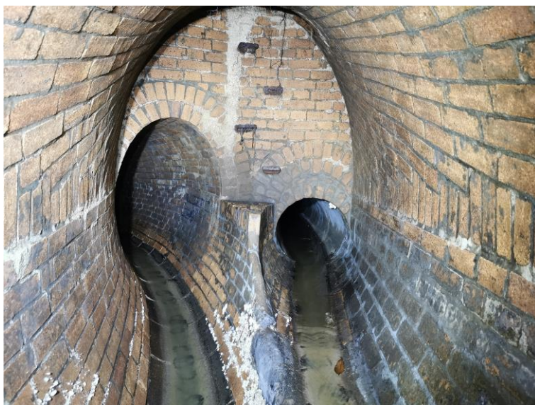
Obr. 8-3- pohled na spojnou komoru Š46SK [zdroj: Lukáš Havlíček]
