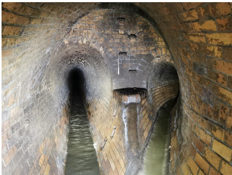
Obr. 8-20 – pohled na spojnou komoru Š22SK [zdroj: Lukáš Havlíček]
