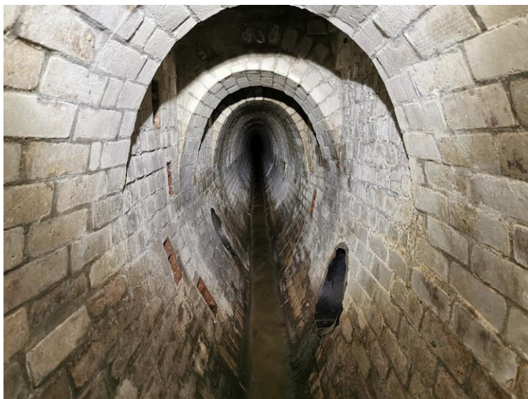
Obr. 8-4 - pohled na dvojici šachet Š31 a Š30 [zdroj: Lukáš Havlíček]
