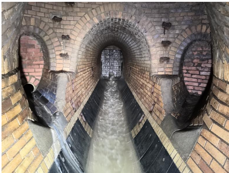
Obr. 8-24 – pohled na spojnou komoru Š2SK [zdroj: Lukáš Havlíček]
