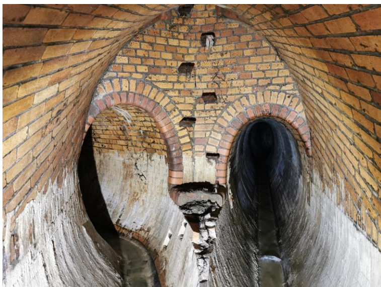
Obr. 8-5 - pohled na spojnou komoru Š24SK [zdroj: Lukáš Havlíček]
