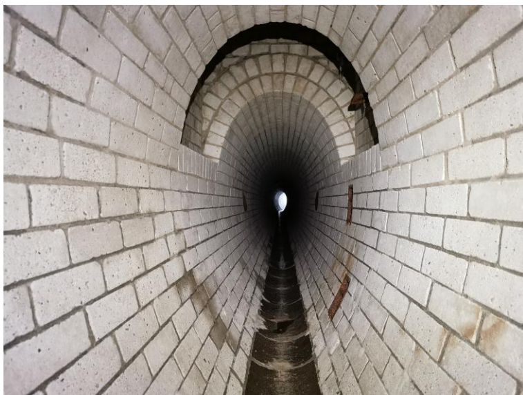
Obr. 8-39 – pohled na výpust' v profilu 800/1430mm [zdroj: Lukáš Havlíček]
