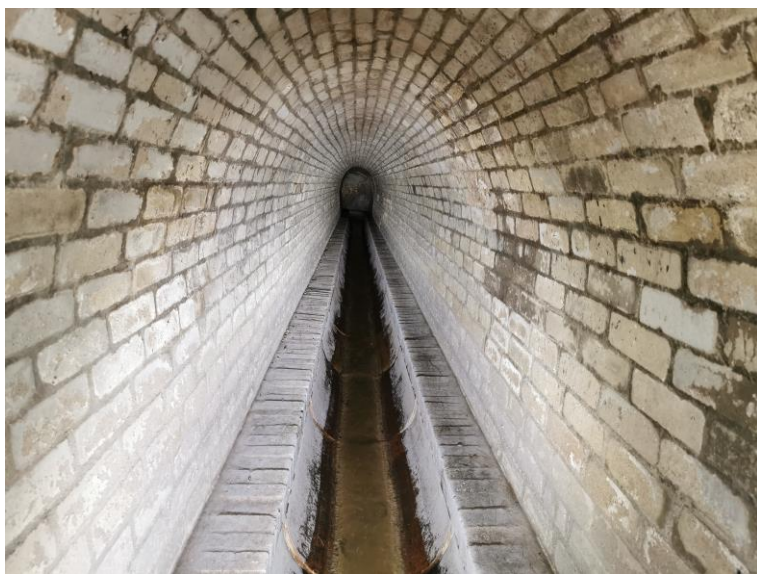
Obr. 8-26 - pohled na atypický profil [zdroj: Lukáš Havlíček]
