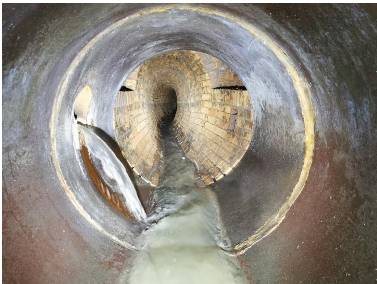
Obr. 8-17 – pohled na přechod z DN1000 na vejčitý profil 700/1250mm v Š46 [zdroj: Lukáš Havlíček]
