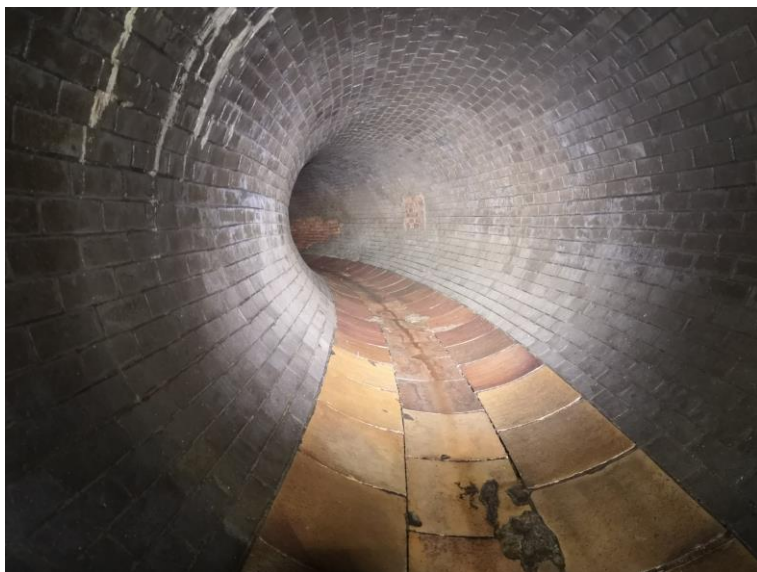
Obr. 8-38 – pohled do výpusti OK_2_FE [zdroj: Lukáš Havlíček]
