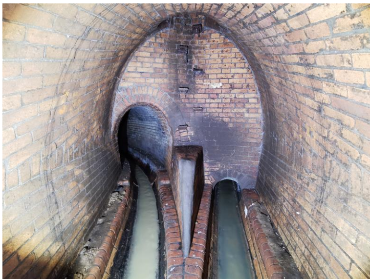
Obr. 8-25 - pohled na spojnu komoru v ulici Křivenická [zdroj: Lukáš Havlíček]
