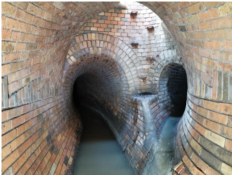
Obr. 8-12– pohled na spojnou komoru Š21SK [zdroj: Lukáš Havlíček]
