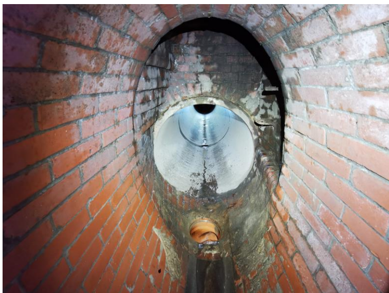
Obr. 8-41 – pohled na oddělovací komoru a začátek trub Vianini [zdroj: Lukáš Havlíček]
