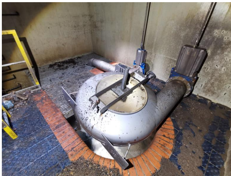
Obr. 9-13 – pohled na vírový regulátor oddělovací komory OK_123_K v Podbělohorské ulici [zdroj: Lukáš Havlíček]
