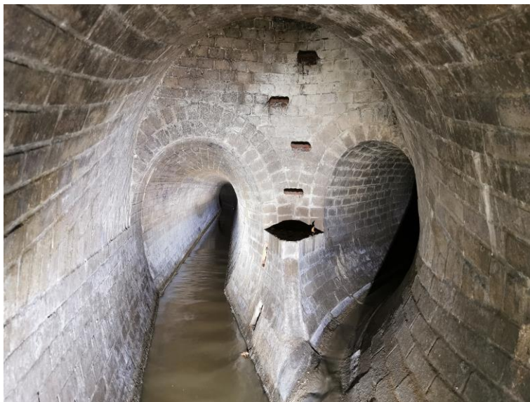
Obr. 8-9 – pohled na spojnou komoru Š50SK [zdroj: Lukáš Havlíček]
