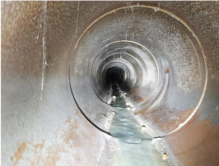
Obr. 3-1 – nejmenší průřezný profil DN800 [zdroj: Lukáš Havlíček]
