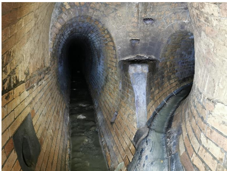
Obr. 8-19 – pohled na spojnu komoru Š27SK [zdroj: Lukáš Havlíček]
