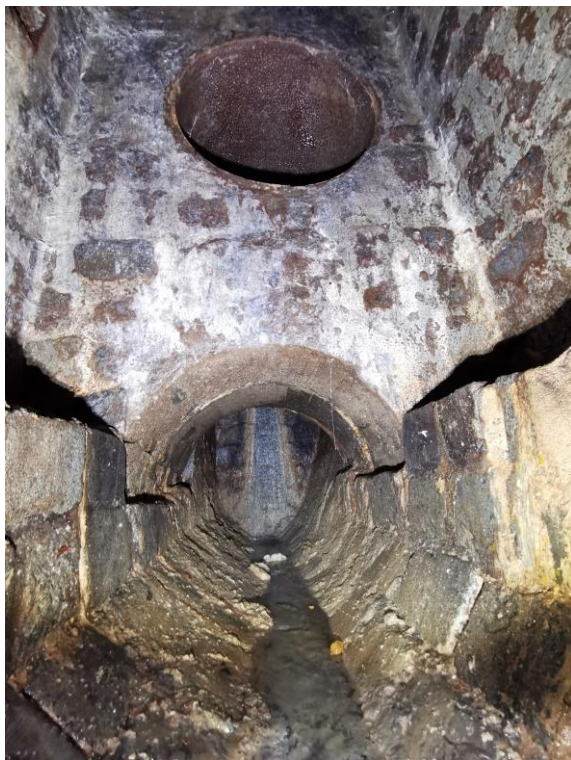
Obr. 8-16 – pohled na atypické spadiště ze šachty Š59 směrem do šachty Š60 [zdroj: Lukáš Havlíček]
