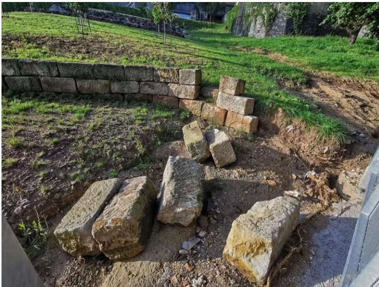
Obr. 9-4 – pohled na pobořenou zídku a vyeroďovanou zeminu [zdroj: Lukáš Havlíček]
