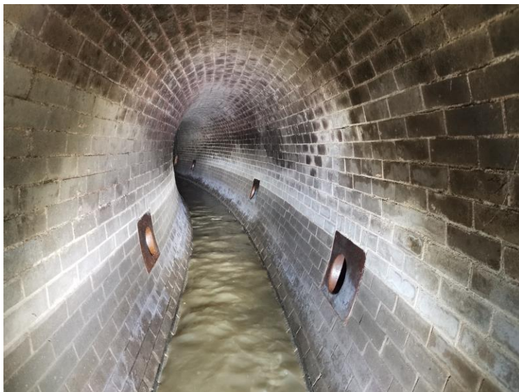
Obr. 8-10– pohled na oblouk sběrače u ulice Heckerova [zdroj: Lukáš Havlíček]
