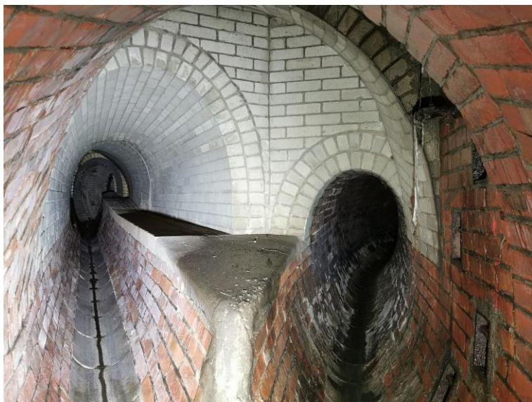
Obr. 8-40 – pohled na atypický profil a na spojnou komoru v ulici Bohnická [zdroj: Lukáš Havlíček]
