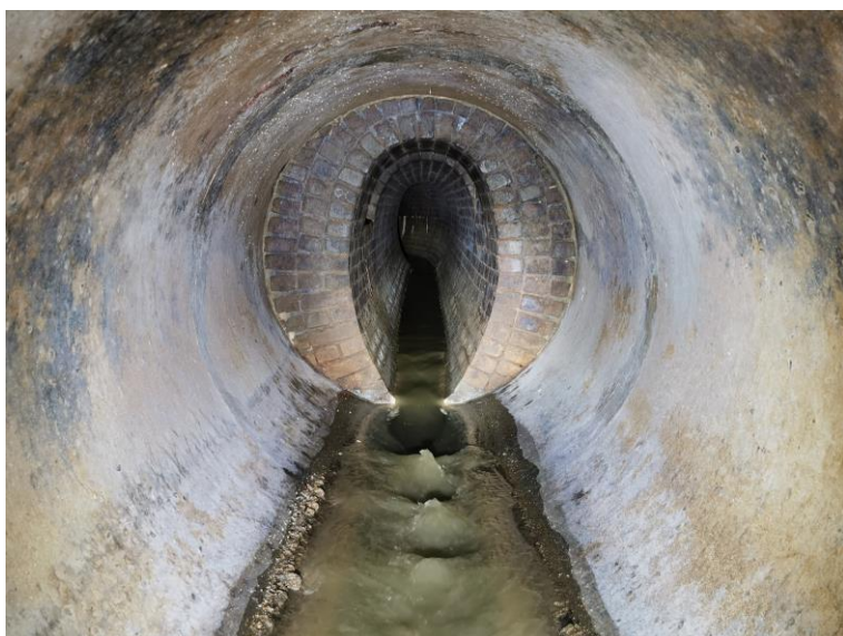
Obr. 8-18 – pohled na přechod z vejčitého profilu 700/1250mm na DN1500 [zdroj: Lukáš Havlíček]
