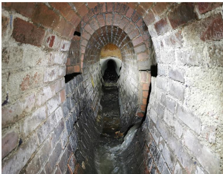
Obr. 8-27– pohled na přechod z DN800 na vejčitý 600/1100mm a na přítok trubní stoky z psychiatrické léčebny [zdroj: Lukáš Havlíček]
