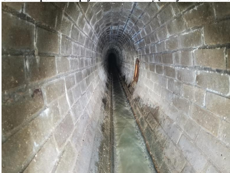
Obr. 8-30 - pohled do stoky 600/1100 od spojn  komory Farky [zdroj: Lukáš Havlíček]
