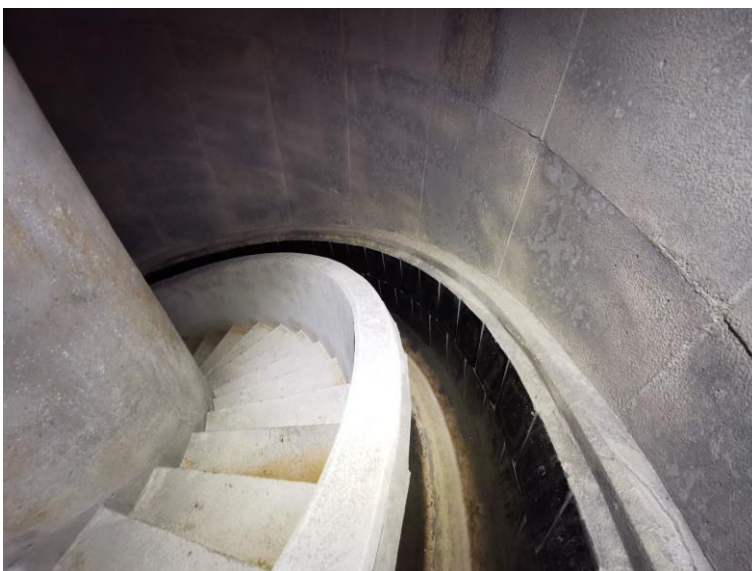
Obr. 9-11 – pohled na spirálový obtok spadiště Nad Novou Libní [zdroj: Lukáš Havlíček]
