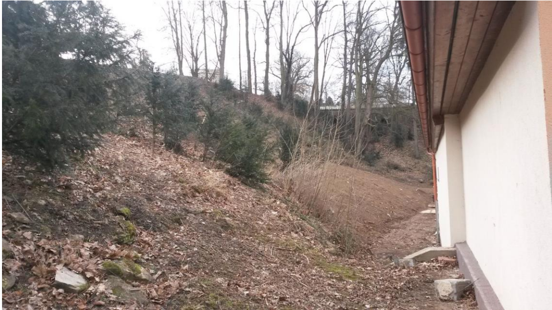
Pohled na patu svahu.
