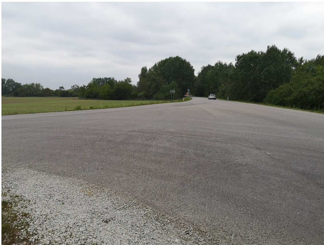
Príloha č. 2 – nehodový úsek - Sobieskeho-/Kamenická cesta/ -Spojovacia cesta II/564 – smer Kamenica nad Hronom
