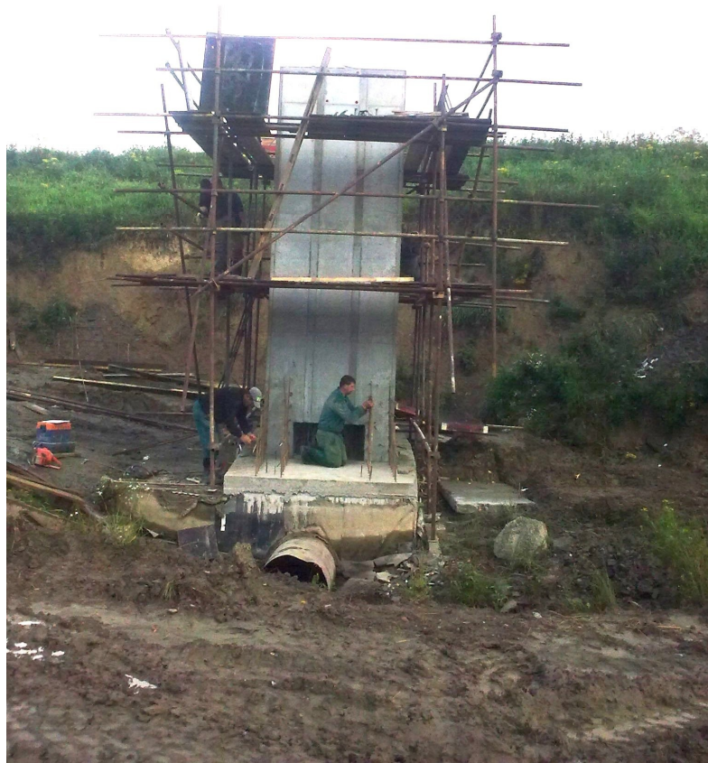
Obr. č. 9 - Vodní nádrž Čermná – v průběhu realizace 74
