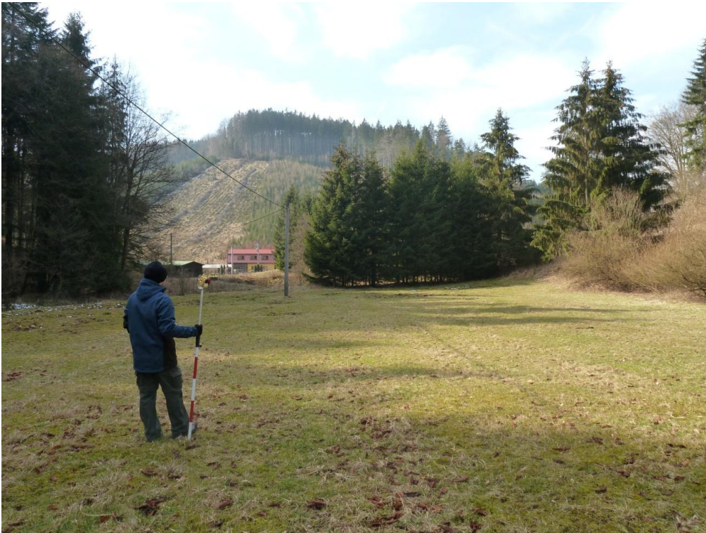
Fotografie č.1: Elektrické vedení procházející přes lokalitu II
