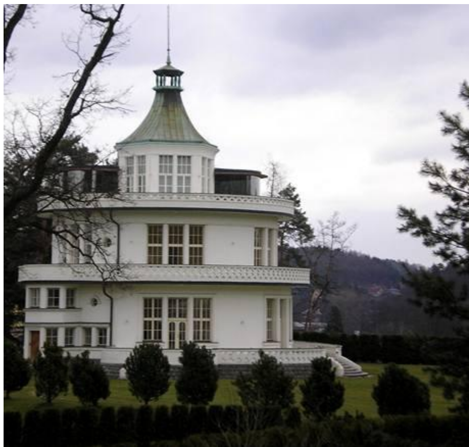
Vila ing. Františka Janečka s dnešním moderně předělaným interiérem.
