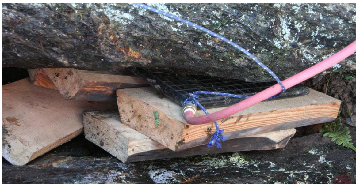
Obr.65 Založení pneumatické podušky (archiv autora)
