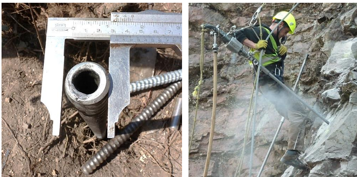
Obr.83 Injektovatelná tyč R 32 N (vlevo), zavrtávání tyče ve stěně (vpravo) (archiv autora)
