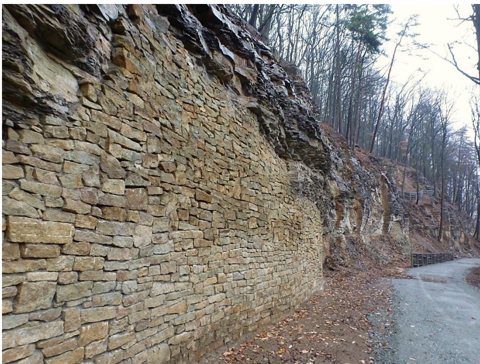
Obr.68 Babiččino údolí, podezdění rozměrného převisu potštejským pískovcem (archiv autora)
