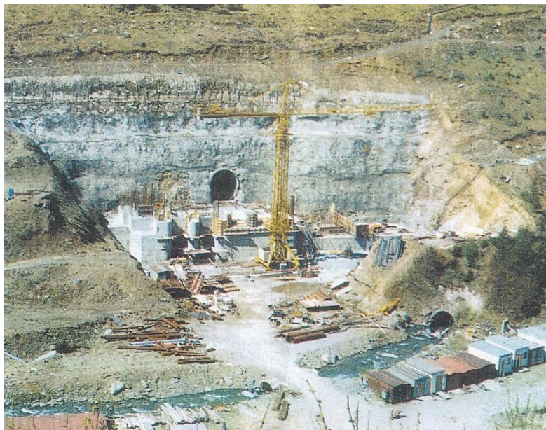
Obr.104 PVE DS, betonáž sdruženého objektu v dočasně zajištěném stěnovém lomu, patrná prorážka odpadního tunelu č.1, vpravo dole obtoková štola (archiv autora)
