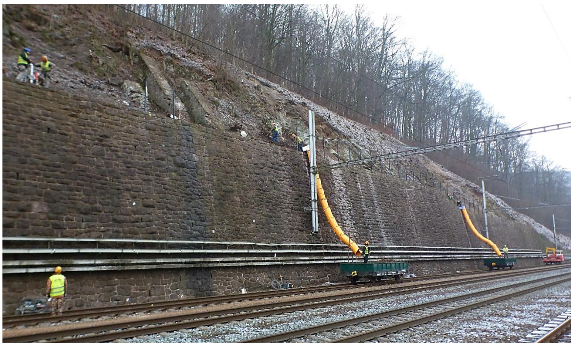
Obr.78 Železniční trať č.260 Brno - Česká Třebová, zárubní zeď v ŽSt Adamov (archiv autora)
