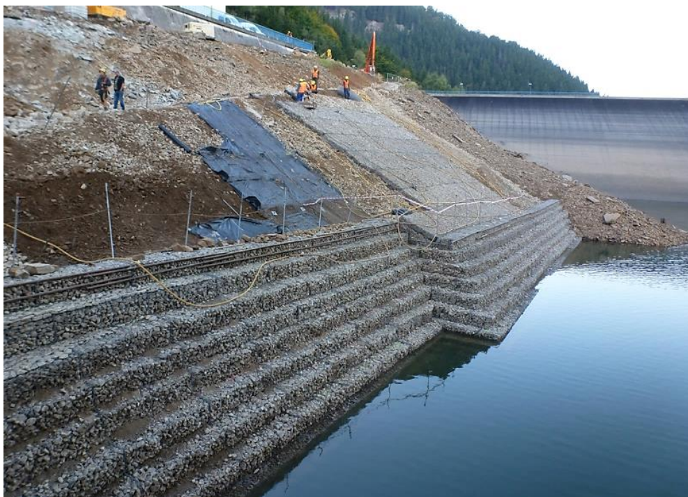
Obr.108 PVE DS, práce probíhaly kontinuálně i během zatápění, patrné opevnění břehového pásma (archiv autora)
