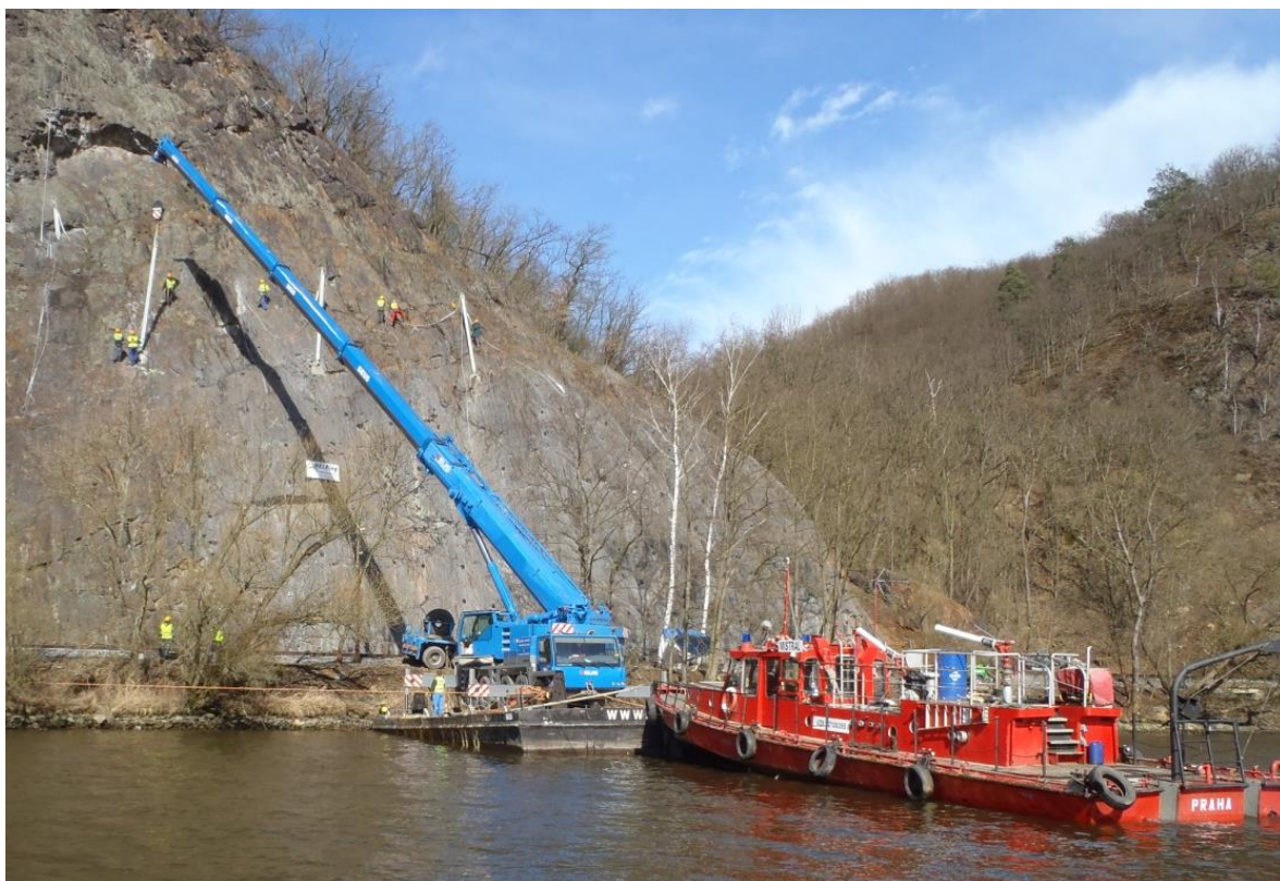
Obr.56 Instalace DB pomocí remorkéru a mobilního jeřábu, Skochovická skála (archiv autora)
