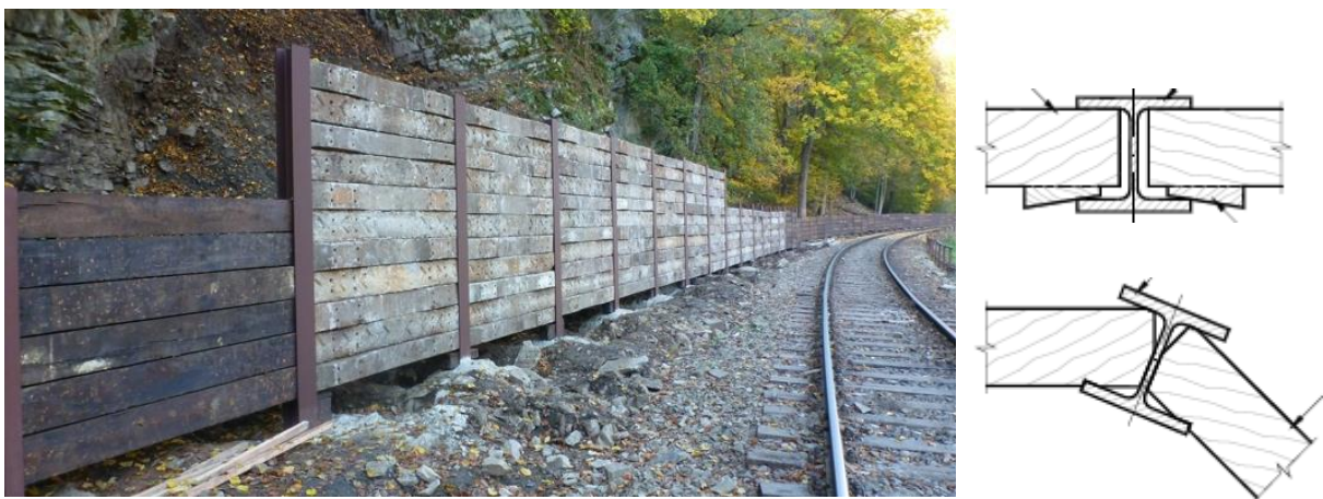
Obr.43 Realizace výplně palisády z výzisku u trati č. 251 Žďár n. S. – Tišnov v km 85,650 (archiv autora)
