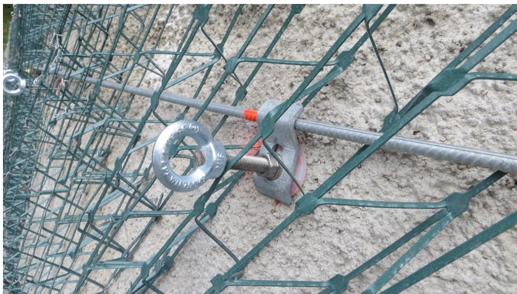
Obr.73 Detail možné aplikace na kolmou zárubní zeď (foto poskytl R. Krismer)
