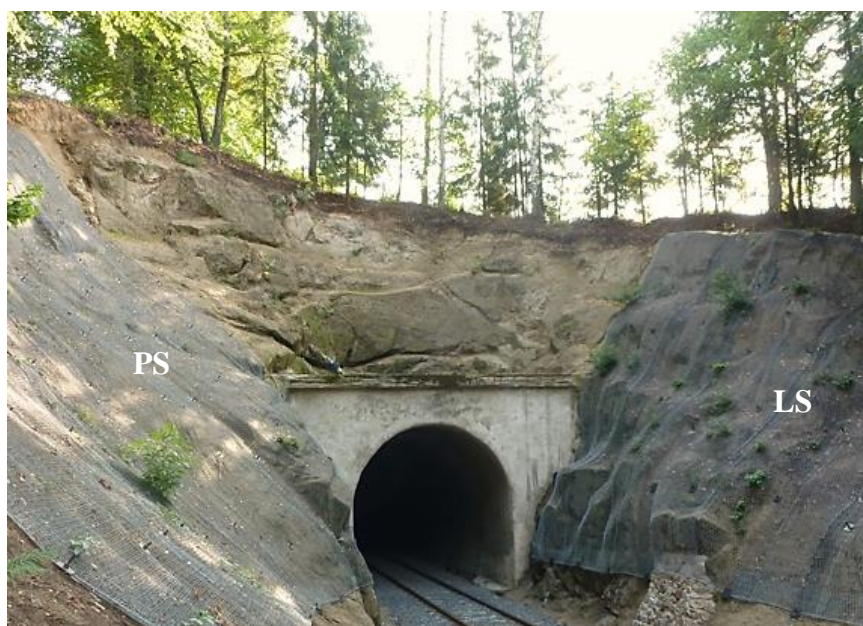
Obr.99 Železniční trať č.036, jablonecký portál prosečského tunelu v km 10,215 (archiv autora)
