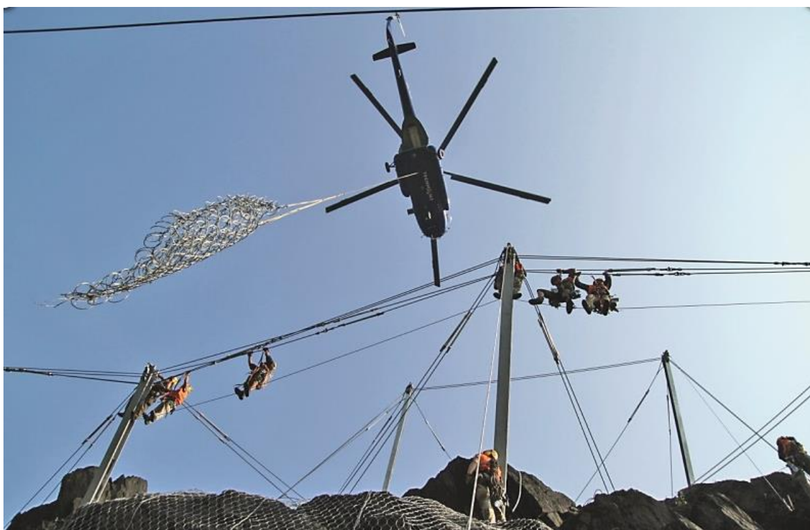
Obr.57 Instalace DB pomocí vrtulníku Mi-8, vrch Kalvárie – Libochovany (upraveno podle www.strixchomutov.cz )
