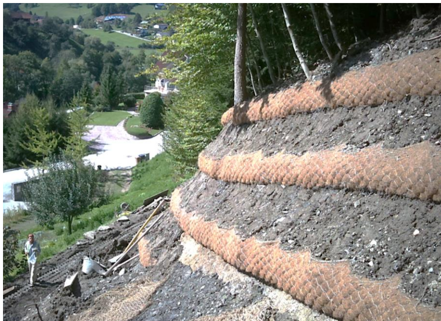
Obr.76 Chorvatsko - sanace poloskalního svahu (foto poskytl M. Šubic)
