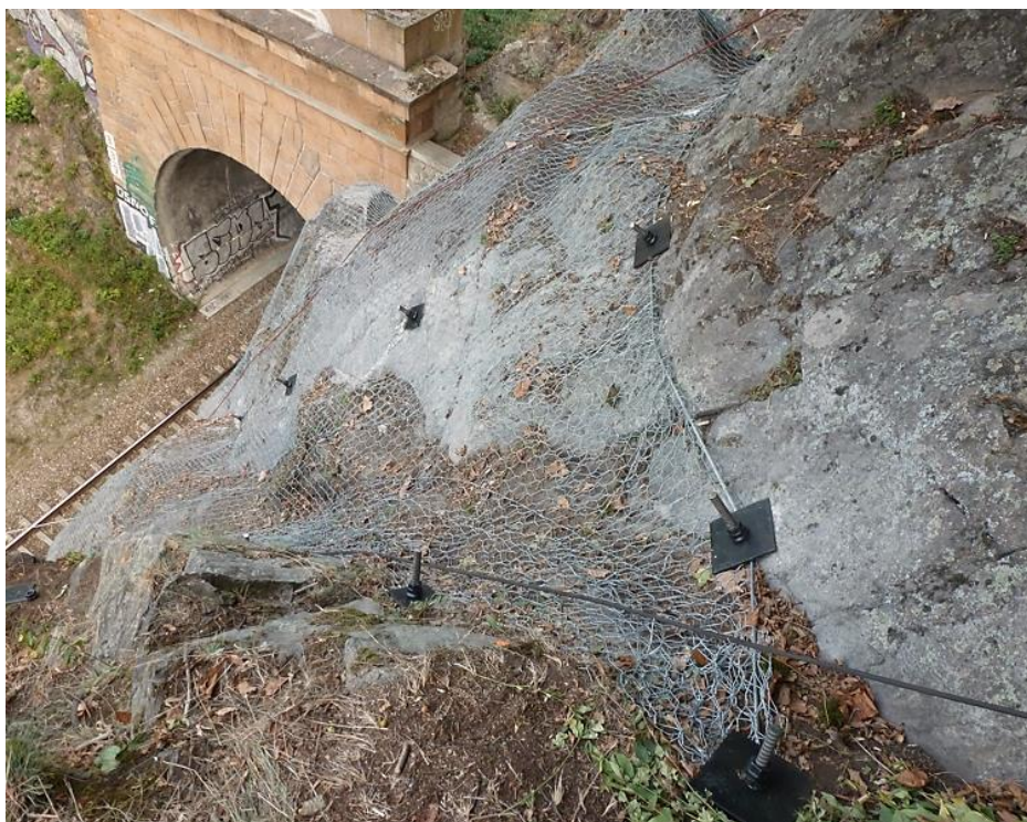
Obr.80 Tunel č. 8/1 - sanace skalní stěny u brněnského portálu, granodiorit typu Blansko (archiv autora)
