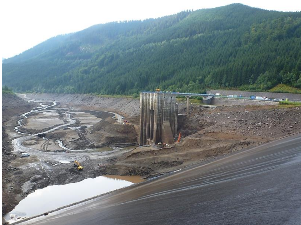
Obr.105 PVE DS, vypuštěná dolní nádrž s viditelnou nátokovou stranou sdruženého objektu (archiv autora)
