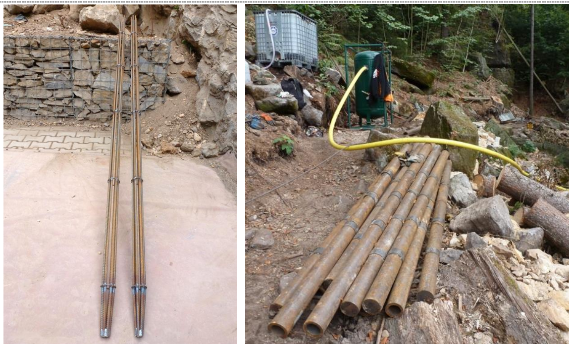
Obr.82 Tišnov – prutová výztuž MP (vlevo); Dolní Žleb – trubková výztuž MP (vpravo) (archiv autora)
