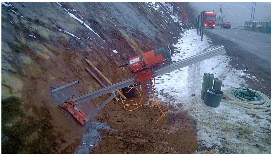
Obr.90 Lokalita č.12 u silnice I/102 Zbraslav – Štěchovice, jádrové vrtání \varnothing 50 mm (archiv autora)
