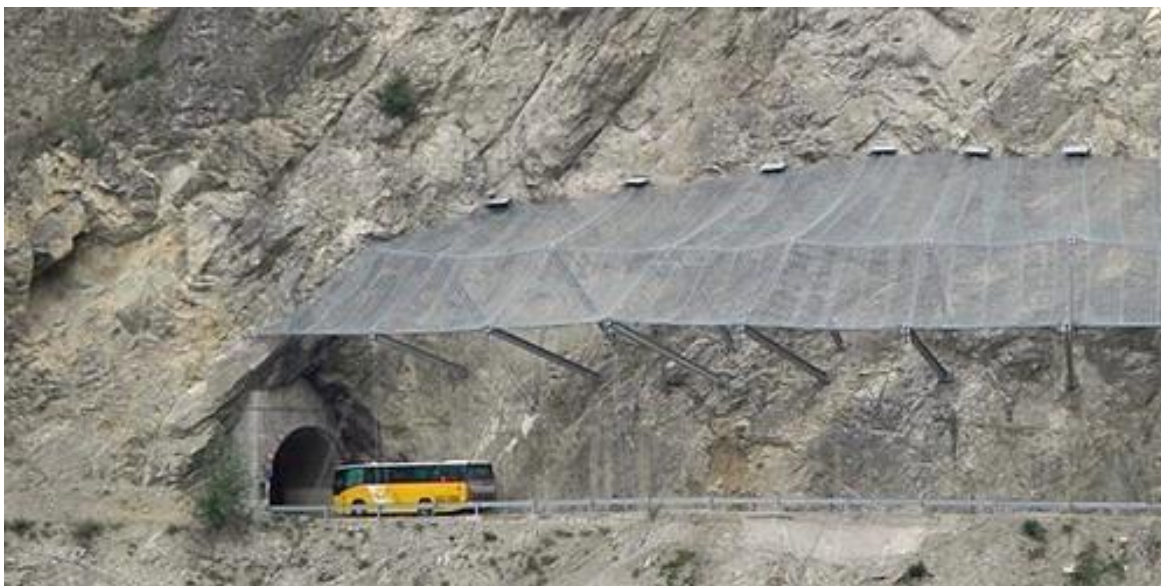
Obr.51 Příklad konstrukce ochranné galerie (upraveno podle www.geobruigg.com)
