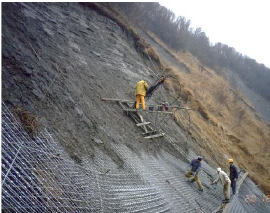
Obr.74 Silnice mezi Štýrskem a Sv. Valentýnem v Rakousku - sanace skalního svahu s použitím 3-D prvků (foto poskytl R. Krismer)
