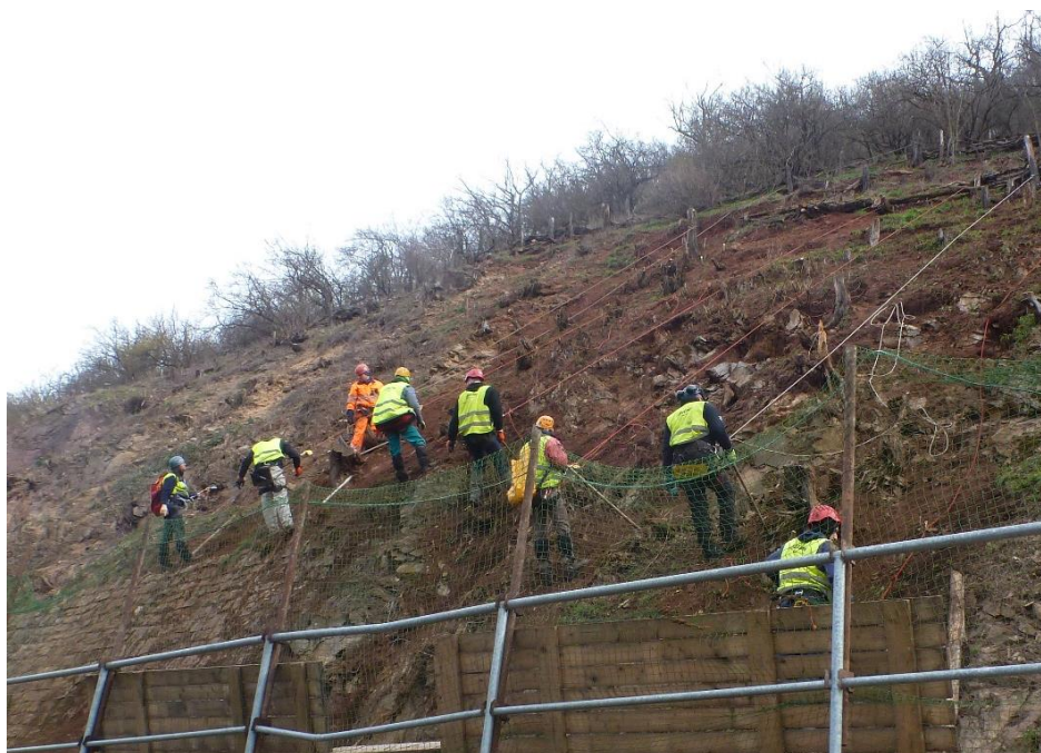
Obr.64 Tišnov-Trmačov, očištění skalní stěny (archiv autora)
