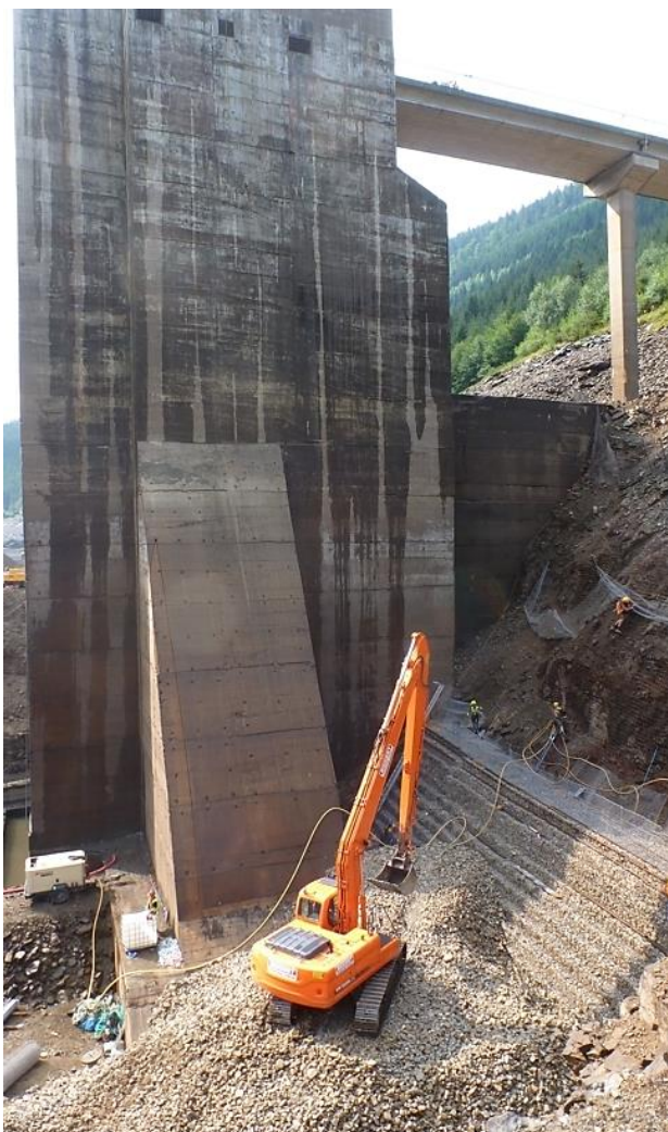
Obr.109 PVE DS, rychlost výstavby (vlevo) a rozpočet vyžadovali optimalizaci kotevních prvků (vpravo)
