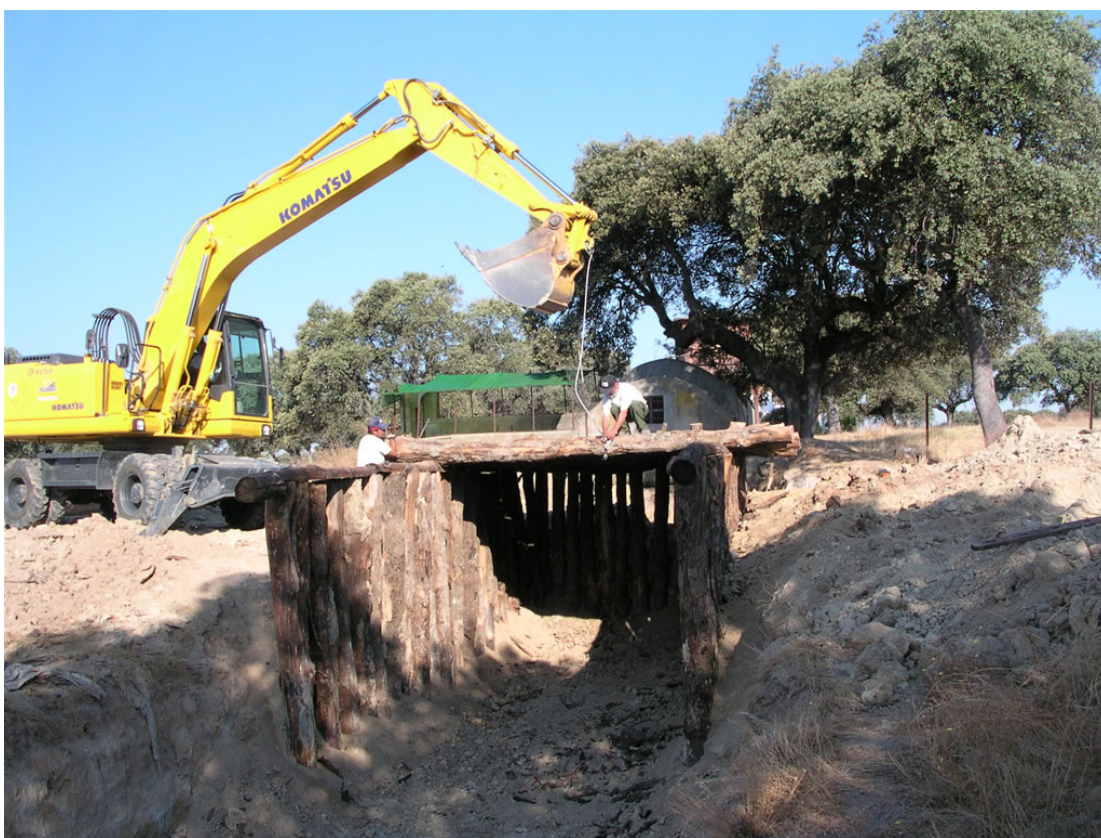
Obrázek 15 Španělsko Extremadura – výstavba (Zdroj: Holzer)
