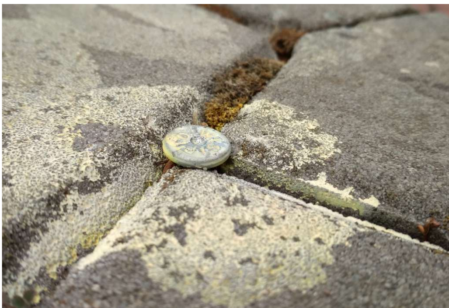
Obr. 8: Ukázka stabilizace měřického bodu [Zdroj: archiv autora]
