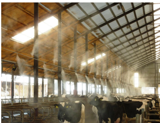
Obrázek č.6: Systém ochlazování stájového vzduchu lehkým mlžením [6]
