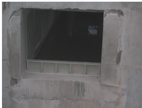
Obrázek č.36: Přeronový kanál s plastový hradítky a vyústění do skladovací jímky [16]
