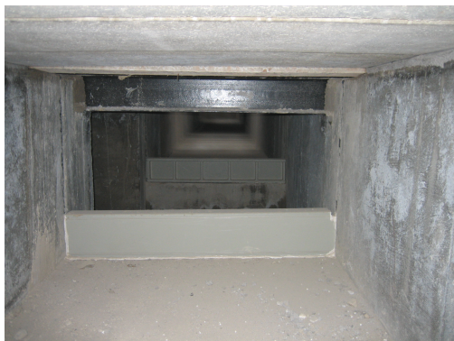
Obrázek č.36: Přeronový kanál s plastový hradítky a vyústění do skladovací jímky [16]
