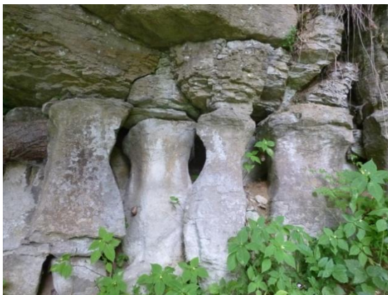
Obr. 38: Hlavní předmět ochrany jsou pískovcové sloupky.
