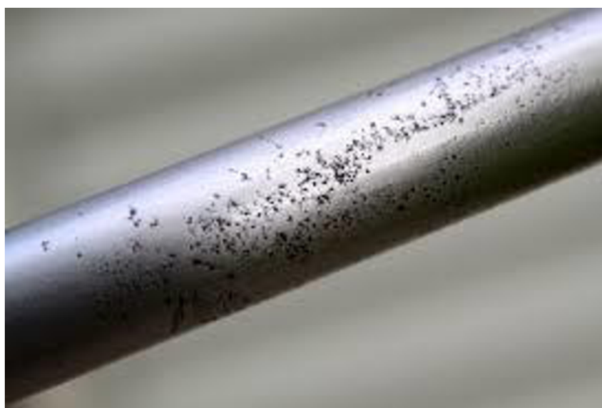
Obr. 9 Ukázka koroze zvané pitting [12]
