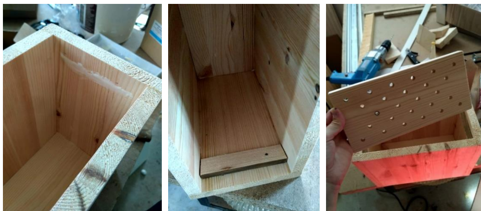
Obrázek 66 Lepení dřevěné zarážky (zdroj: autor)
