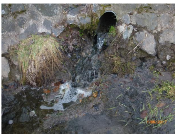
Odběrný profil 3 – detail výpusti z ČOV, březen
