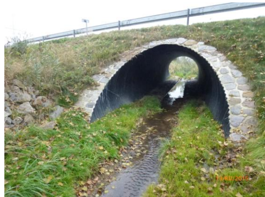
Odběrný profil 4 – pohled na propustek pod silnicí
