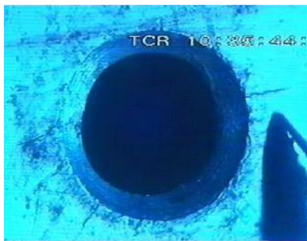
Obr. 1. Díra po nýtu s vyditelnými trhlínami
