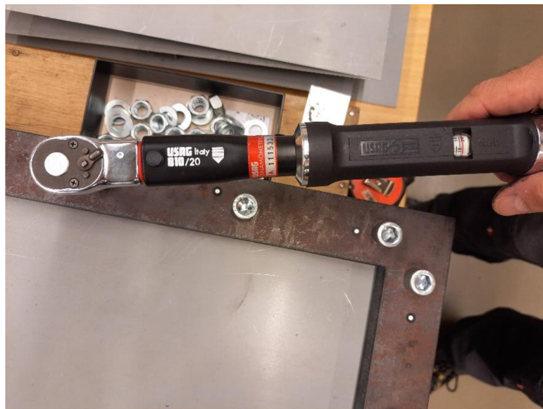
Obr.29 utahení šroubů na požadovaný utahovací moment
