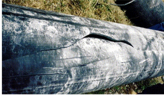
Obr. 11: Pozdĺžna trhlina, HDPE trubka [35]
