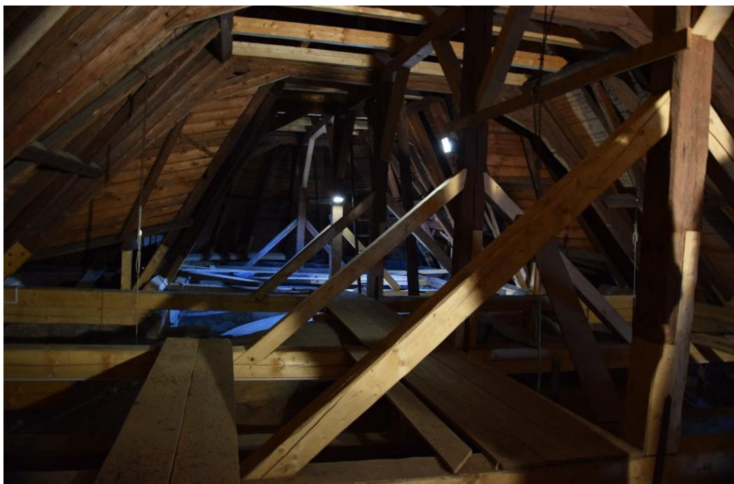
obr. 22– pohled z hlavní lodi směrem na presbytář
