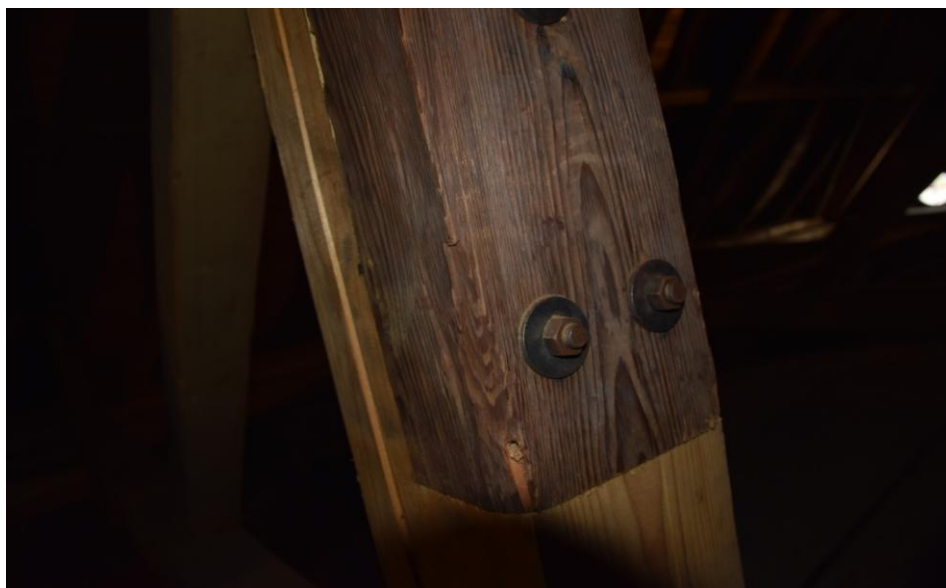
obr.24 – Spojení původního a nového sloupku
