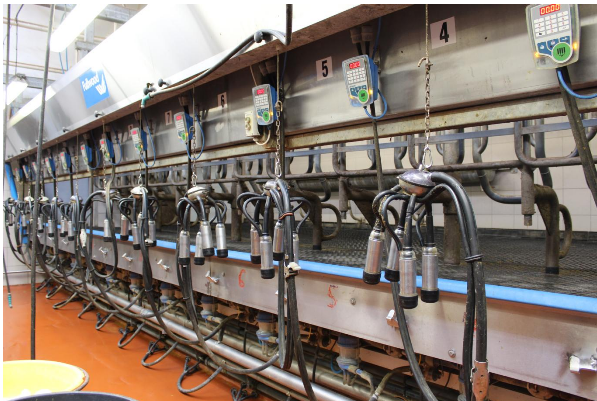
Obr. č. 9. Detail dojírny
