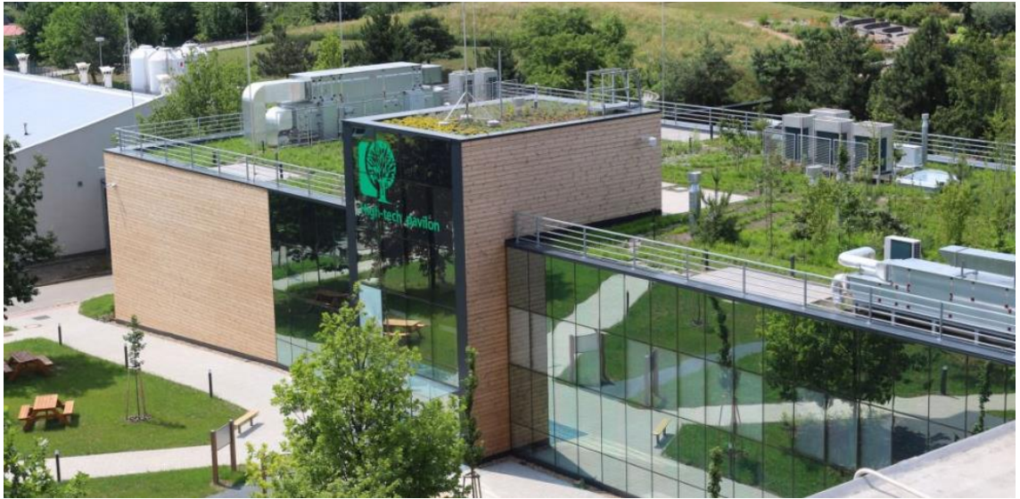
Obr. 11 Zelená střecha kampusu ČZU (ČZU, 2019)
