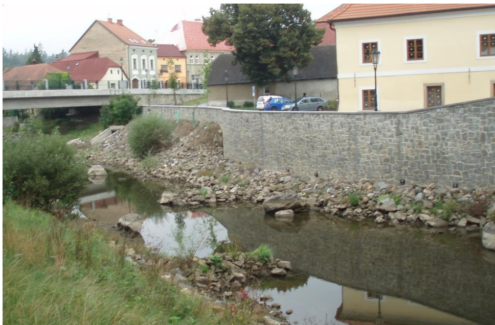
Obrázek 5: Protipovodňová zídka v centru města slouží jako ochrana proti stoleté vodě (zdroj: Blažková, 2015)
