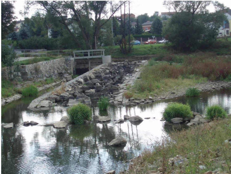
Obrázek 13: Rybí přechod u areálu Prádelny Kyselý (zdroj: Blažková, 2015)
