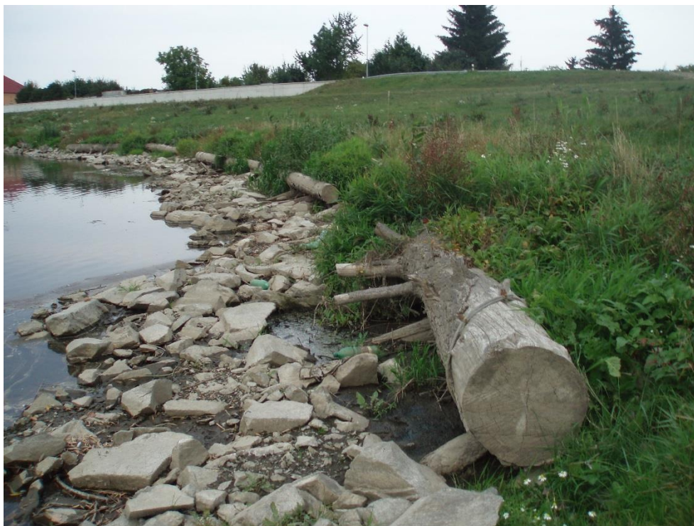
Obrázek 10: Bitotechnické opevnění řeky Moravy stabilizuje břehy a vytváří úkryt pro vodní živočichy (zdroj: Blažková, 2015)
