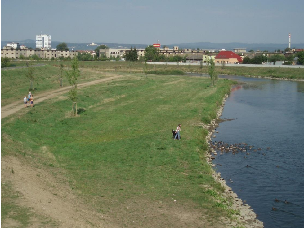
Obrázek 8: Rozšířená berma na řece Moravě v Olomouci je vhodným místem pro rekreační aktivity a navíc vytváří prostor pro rozliv při vyšší hladině vodního sloupce (zdroj: Blažková, 2015)
