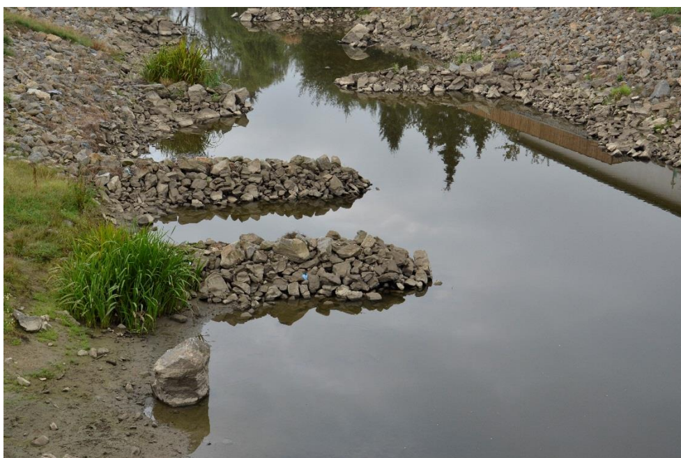
Obrázek 2: Příčné výhony ze záhozového materiálu, díky kterým má postupem času dojít k vytvoření meandrující kynety (zdroj: Blažková, 2015)
