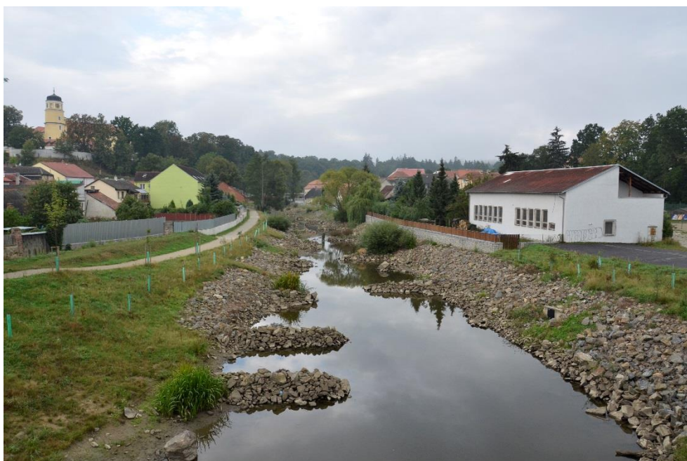
Obrázek 13: Koryto řeky Blanice je po realizování projektu opevněno pohozem, jsou zde vytvořeny příčné kamenné výhony a podél řeky vede nezpevněná cesta (zdroj: Lampartová, 2015)
