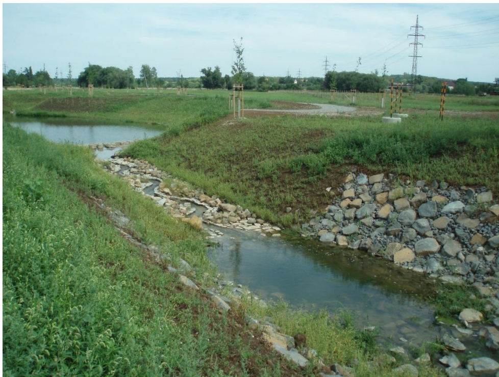
Obrázek 4: Koryto vodního toku a tůň vytvořená v rámci revitalizace slepého ramene řeky Jizery v Benátkách nad Jizerou (zdroj: Blažková, 2015)
