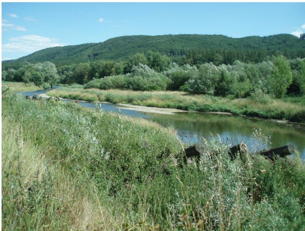
Obrázek 7: Lokality Bečvy u Familie a kamenné výhony (na levé straně břehu), které slouží k rozvolnění koryta řeky a stabilizaci břehů; výhony jsou dnes značně zarostlé vegetací (zdroj: Blažková, 2015)
