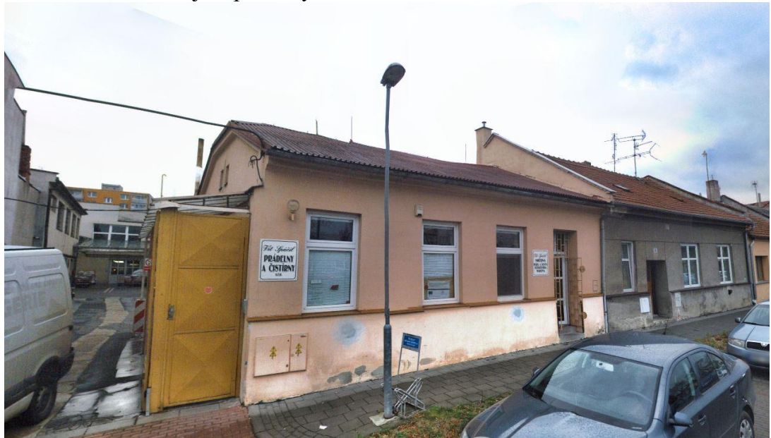
Obrázek 2 – Pohled na objekt prádelny z ulice
