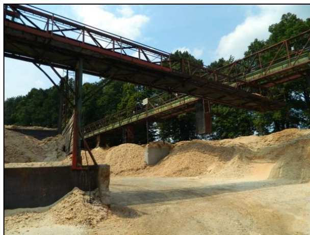
Obrázek č. 9: Skládka pilin a štěpky
