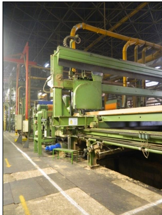
Obrázek č. 13: Krácení navrstveného dřevovláknitého koberce kotoučovou pilou
