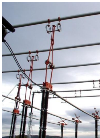
Obr. 18 - Pantografický typ odpojovače [13]
