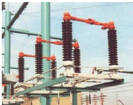
Obr. 17 - Rotační typ odpojovače [13]
