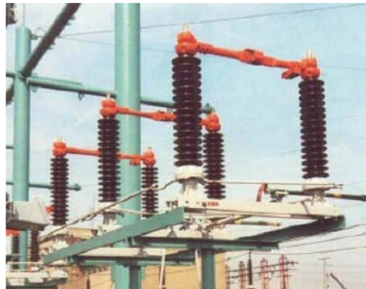
Obr. 17 - Rotační typ odpojovače [13]
