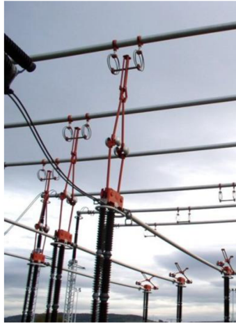
Obr. 18 - Pantografický typ odpojovače [13]
