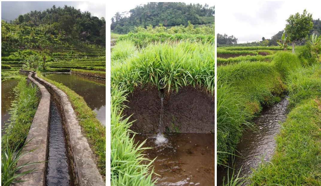
Obr. 11 – 13 – Části zavlažovacího systému – Jatiluwih 2017
