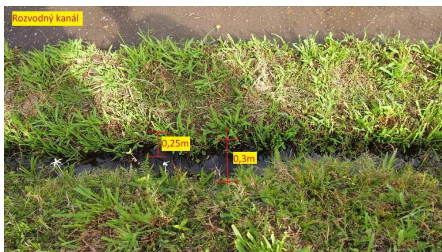
Obr. 23 – Rozvodný kanál Tanah Lot 2017
