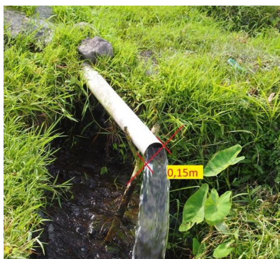
Obr. 24 – Rozvodná trubka – Tanah Lot 2017
