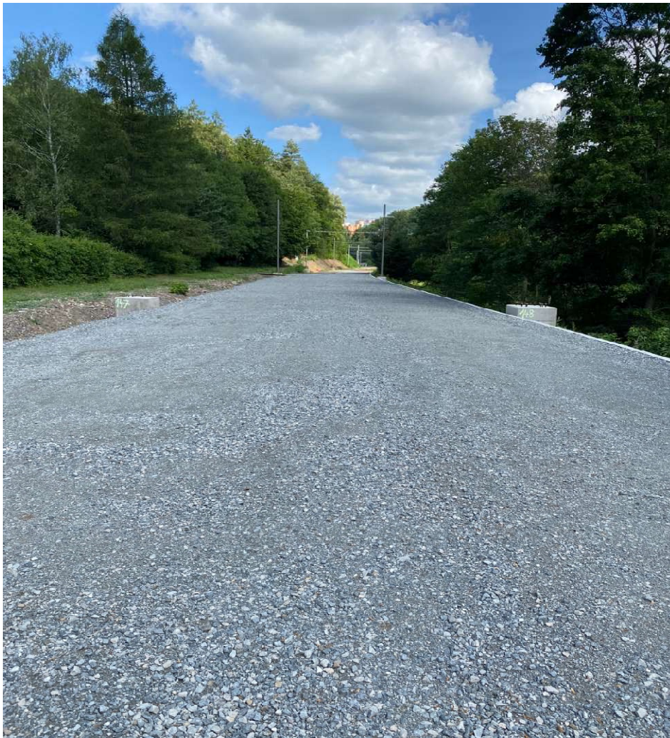
Obrázek 1.3 Pláň tělesa železničního spodku
