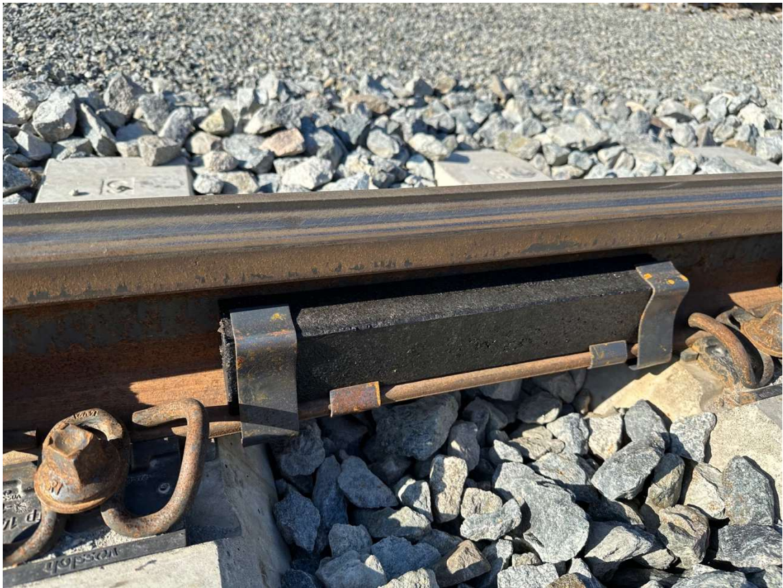
Obrázek 3.2 Bokovnice připevněná ke kolejnici
