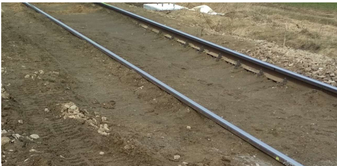
Obrázek 1.2 Znečištěné štěrkové lože
